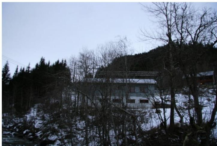
Figur 1 Eksisterende Trafostasjon ca. 313 moh
