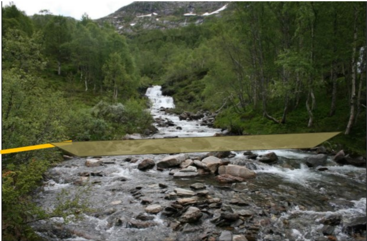
Figur 9 Terskel og starten av kanal i Togrovi - for å føre vann over til inntaket ved Lambagrovi.
