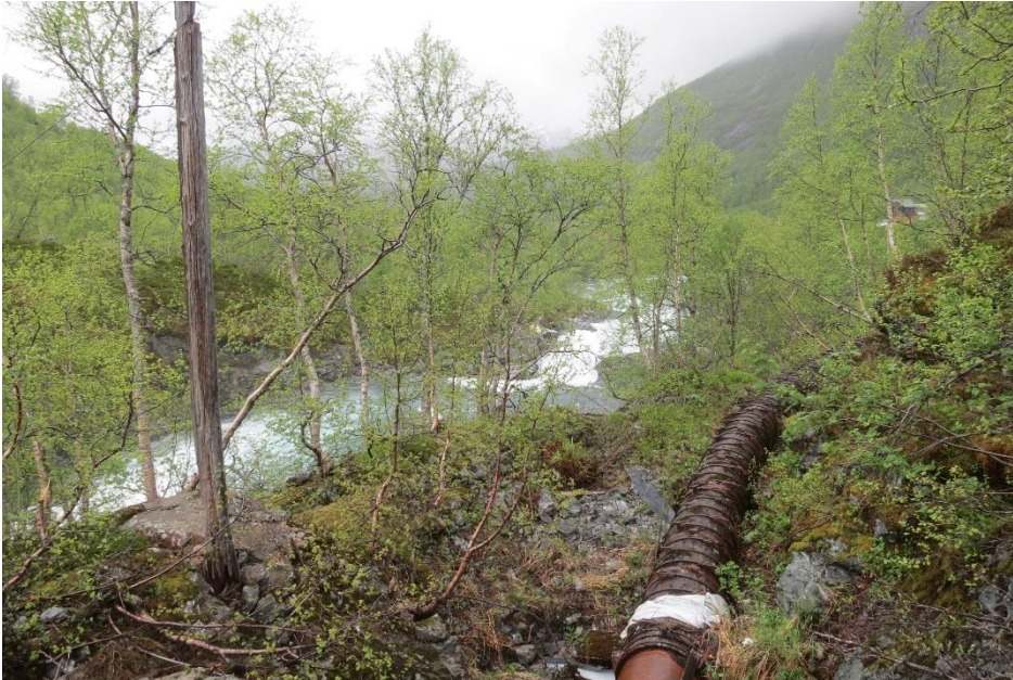
Figur 3 - Eksisterende rørgate i dagen. Ny rørgate skal graves ned i samme trasé.
