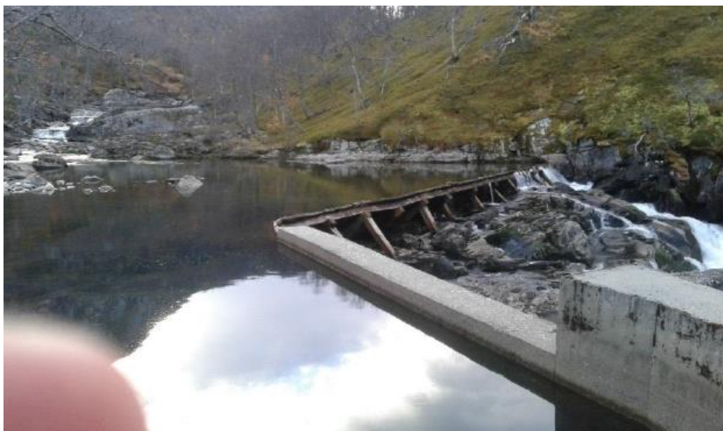
Figur 1 - Eksisterende tredam som skal fornyes. Bildet er hentet fra konsesjonssøknaden.
