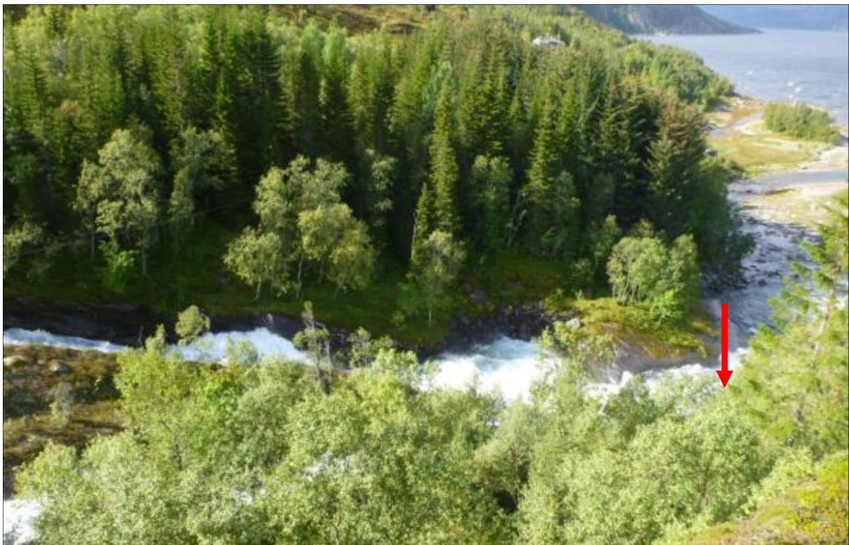
Fig. 10. Utslippet fra kraftstasjonen er planlagt i tunnel til det nederste fossestryket, dvs. med utslippet på kote 3. Foto: Tiltakshaver.
