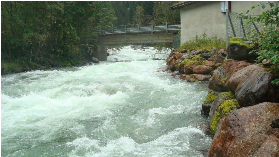
Foto – stor vassføring. Nedre del, kraftstasjon for Budal I til høyre i bildet. Vassføringsdata er ikke kjent/berekna men er estimert til mellom 4 og 7 x middelvassføring (7– 13 m 3 /s).
