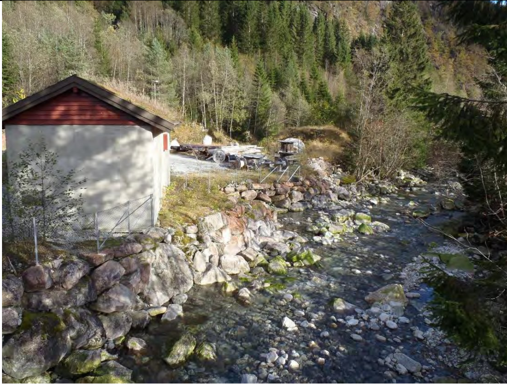
Foto 5: Bilete stasjonsområde. Stasjon Budal I i framgrunnen. Budal II er planlagt der materiallager for Modalen Kraftlag ligg i bakgrunnen.
