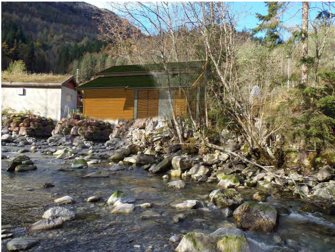
Foto/illustrasjon 6: Ny kraftstasjon for Budal II ved sida av Budal I. Sett nedanfrå i elva.
