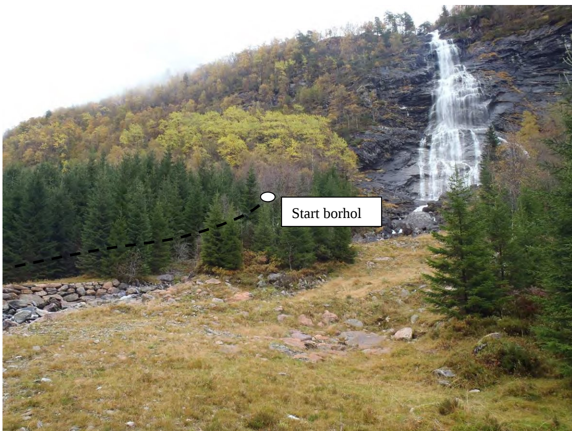
Foto 4: Nedre del av røyrtrasé og påslag for borhol. Ca. linjeføring for trykkrøyr vist ved stipla linje.
