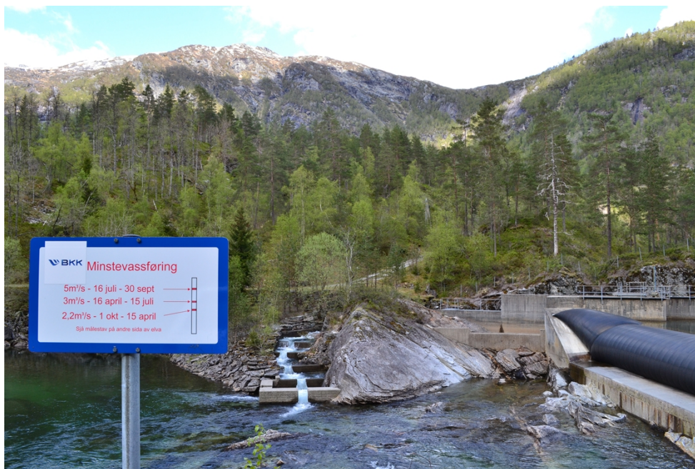
Fig. 18 Laksetrappa ved Almelid er sett i stand og gjer at laks og sjøaure kan gå opp Modalselva til Steinslandsvatnet og opp i m.a. sideelvane Todeilselva og Nåmdalselva, som begge er søkt om kraftverk i. Lenger oppe i elva blei kalkingsanlegget på Espeneset offisielt opna 10.05.16
