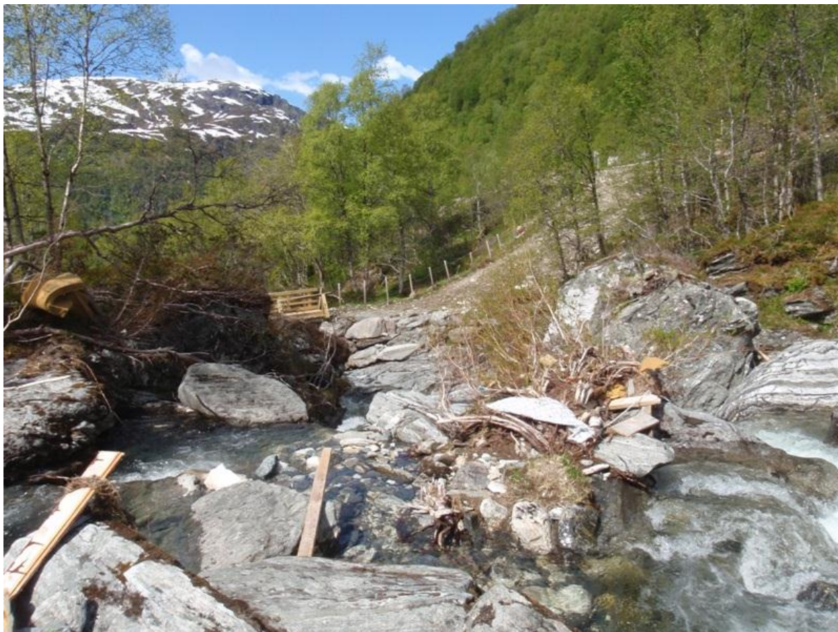
Figur 4 Damstad ved bru, Ommedalstverrelva
