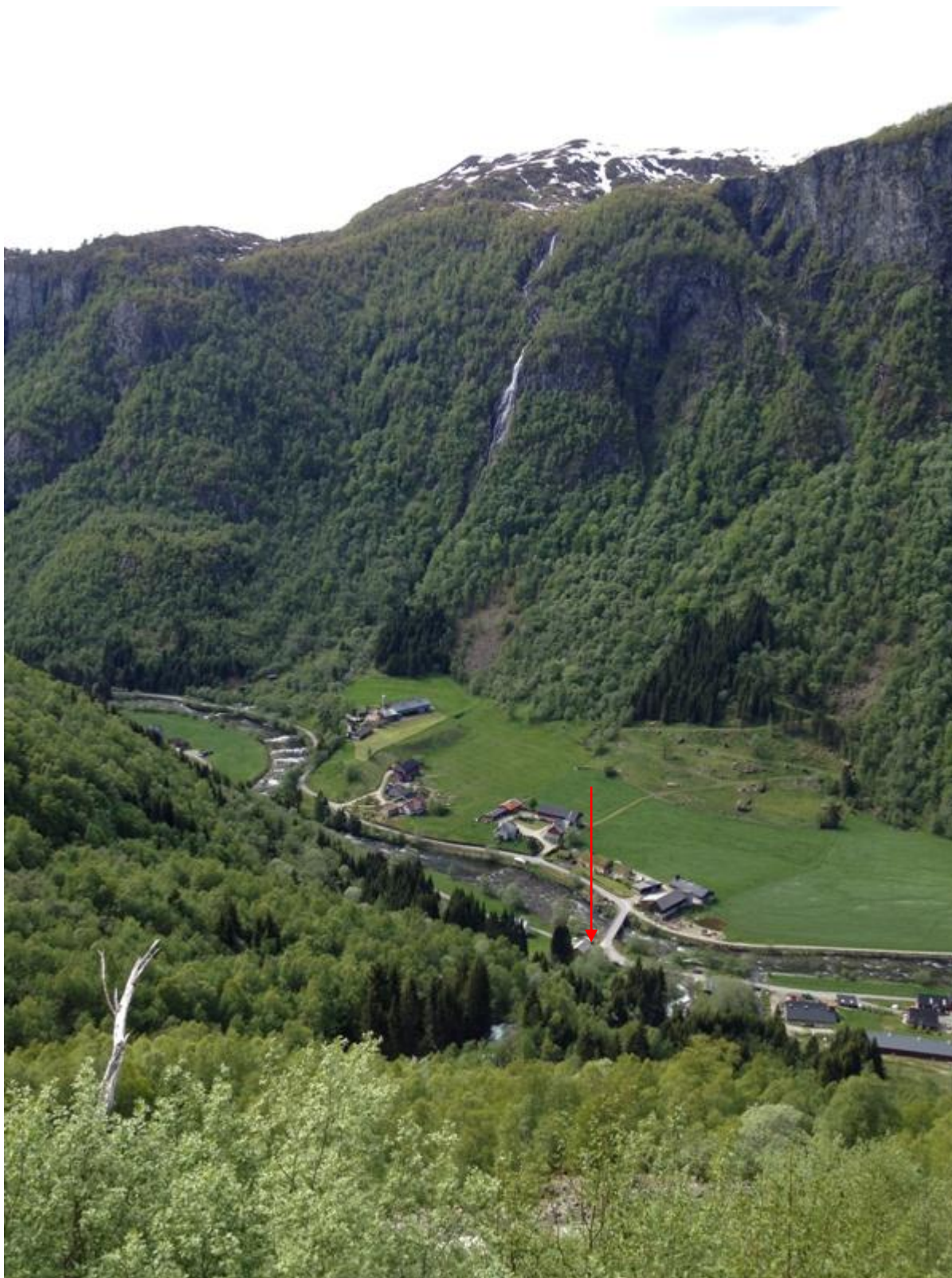
Figur 6 Oversikt over Ommedalen fra eksisterende støylsveg. Pila syner kor kraftstasjonen er planlagt bygd.
