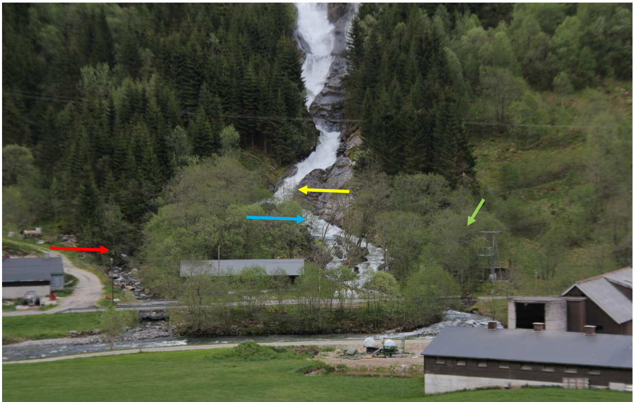
Figur 4-5 Oversiktsbilete: raud pil syner flaumløp, blå pil nedre vandringshinder (A), gul pil øvre vandringshinder (B). Grøn pil syner om lag kraftstasjonsplassering.
