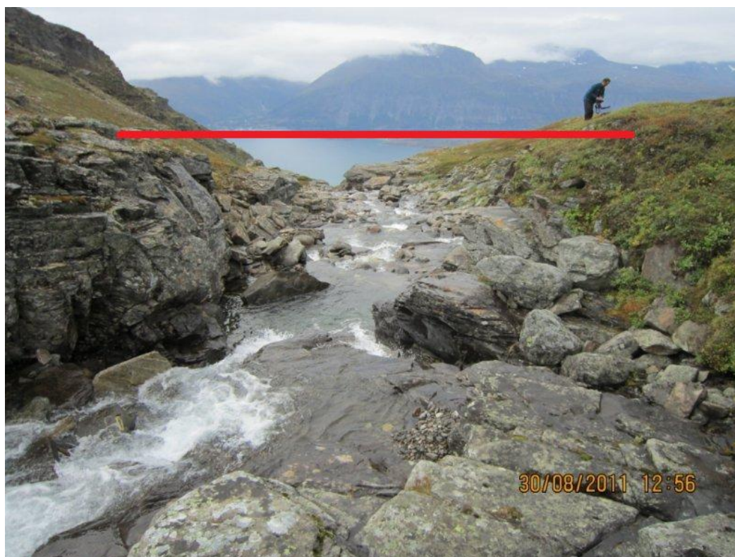
Figur 2-6 Damsted sett nedstrøms. Damkrone ved rød strek. Foto Elvekraft
