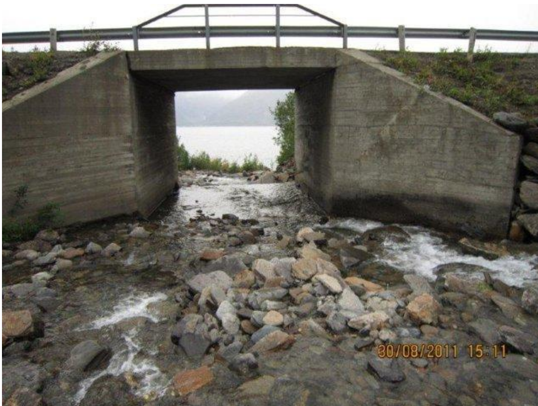
Bilde 6: E6 i bru over Innerelva (H=3,5 m, B=3,5 m). Foto: Elvekraft.
