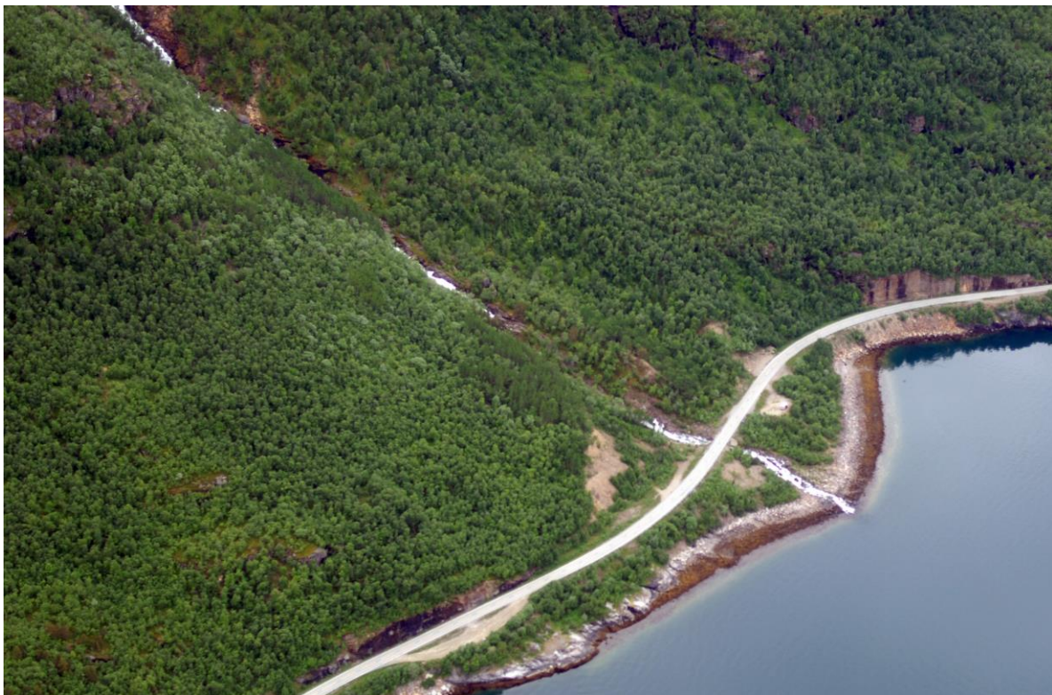
Figur 3. Skråbilde av Innerelva med stasjonsområde og område med nedgravd rørgate. Foto: MAPAID
