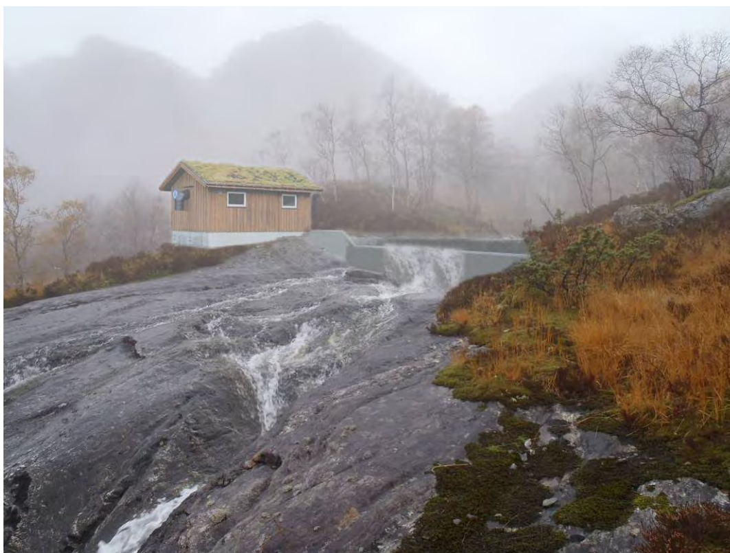
Foto/Illustrasjon 2: Dam/inntak i Seljedalselva sett motstraums. Lukehus og dam illustrert i bilete.
