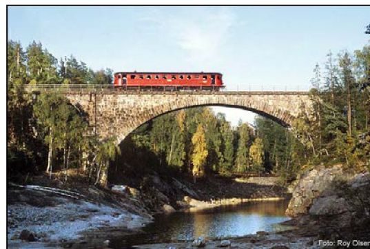
Figur 5 Bøylefoss bru, med tømmerrenna i bakgrunn.
