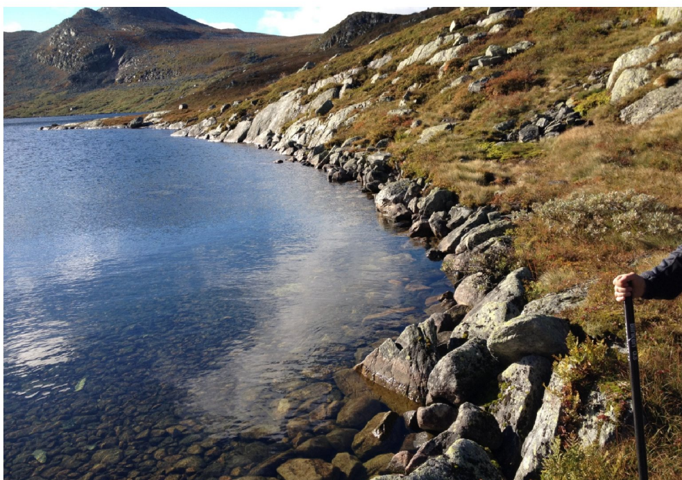
Figur 19 Strandsonen på nord-vest siden av Djupetjønn har et beskyttende lag av grove masser som vil beskytte mot erosjon. Helningen er om lag 1:1.
