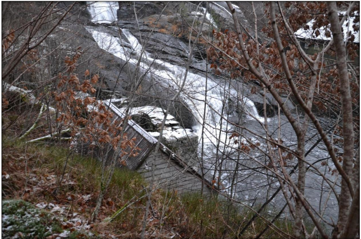
Bilete 10. Taket på den gamle kraftstasjonen og fossen sett frå kjerrevegen.
