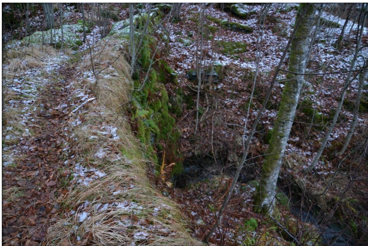
Bilete 12. Kjerrevegeen går over ei gamal bru over ein liten bekk bak stasjonsområde.
