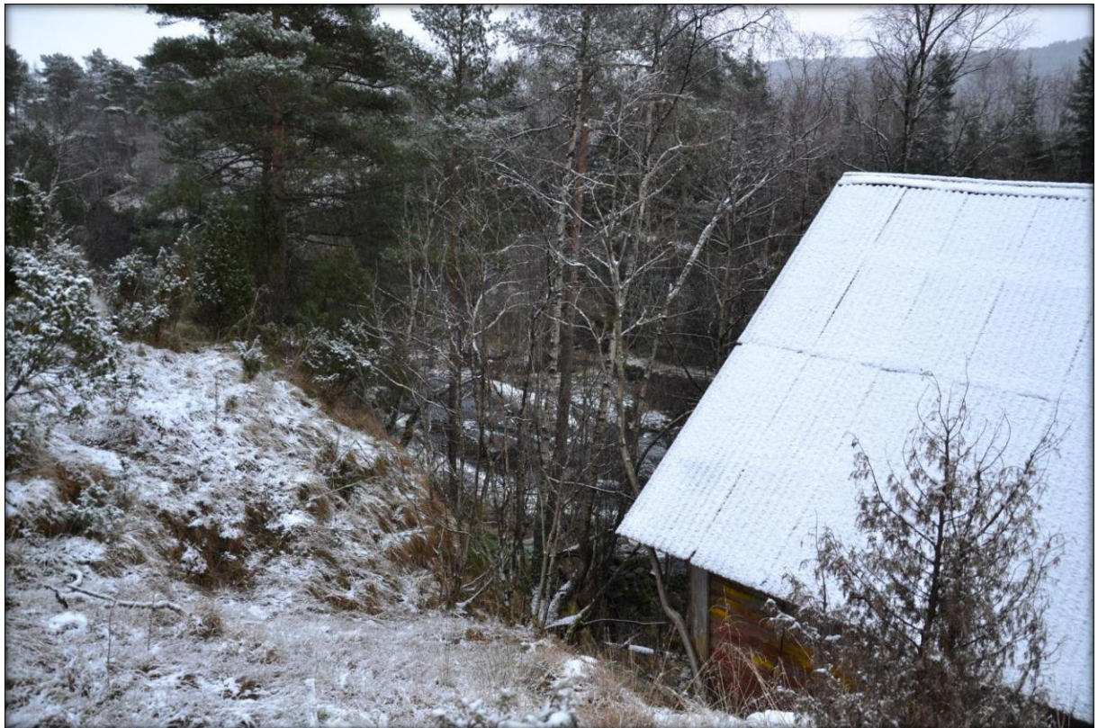
Bilete 31. Baksida av bygget som til hørde dunkefabrikken. Boreholet er tenkt noko til venstre for bilete.
