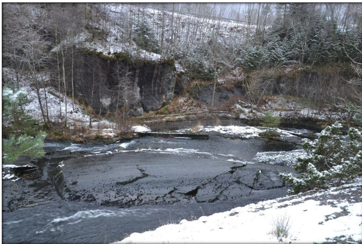
Figur 20. Elva rett nedstraums inntaket. Det er i dette området, sør i elva at det er observert jettegryter. Mur kanten ein kan skimta midt i bilete er truleg delar av inntaket til ei gamal øydelagt kvern på sørsida.
