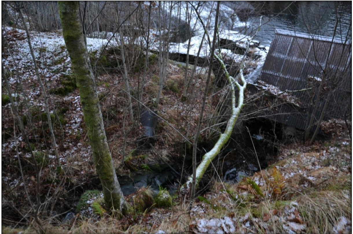
Bilete 13. Bekken fortset ned og under den gamle kraftstasjonsbygningen.
