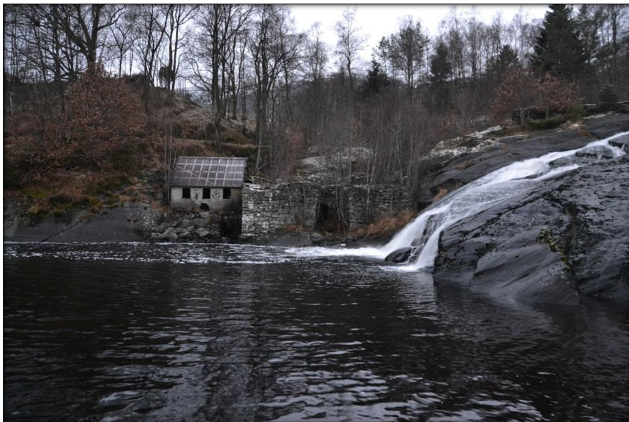
Figur 16. Kraftstasjonen ved utlaupet til Koldalsfossen, vegg i vegg med muren etter den gamle oppgangssaga.
