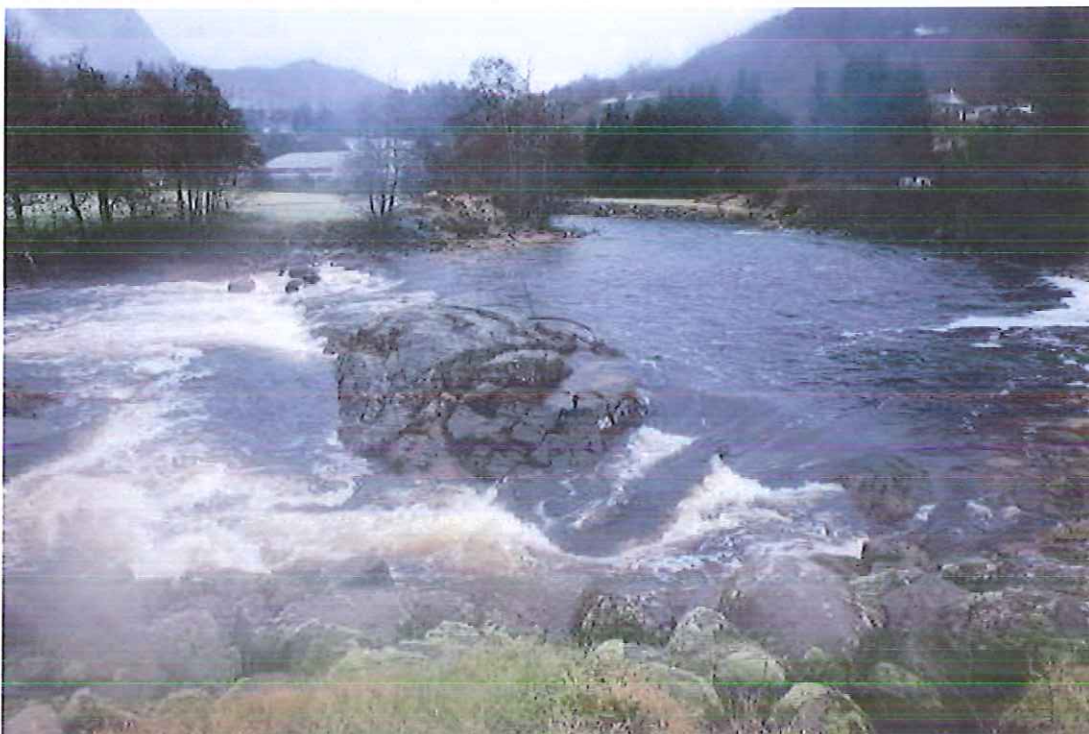
Figur 4. Fra området hvor inntaket er planlagt. Foto: Roy Mangersnes.
