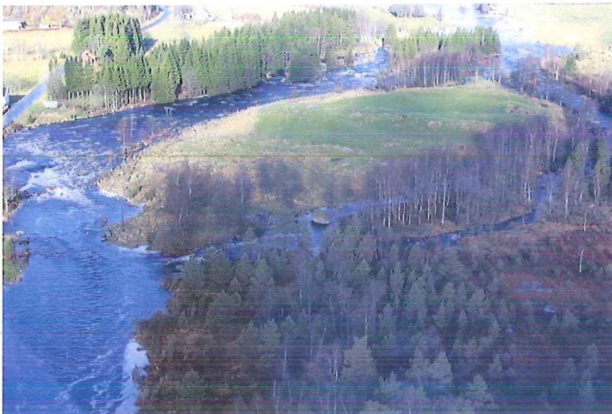
Foto Øya hvor overføringskanalen og kraftstasjonen plasseres.
