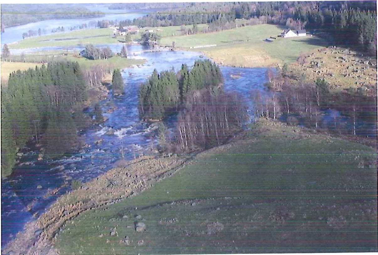
Foto : Inntaksområdet til høyre for den skogkledde øya ved elvedele
