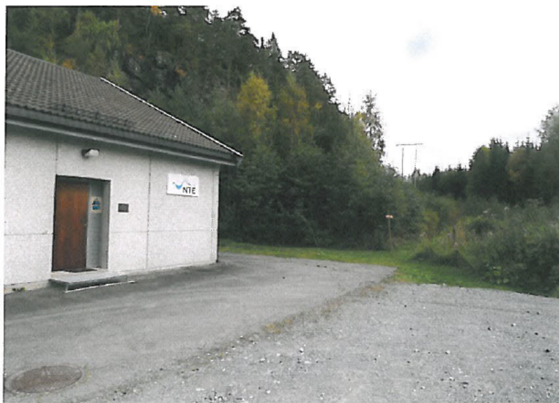
Fig. 15 Frosta trafostasjon. Dagens anlegg
