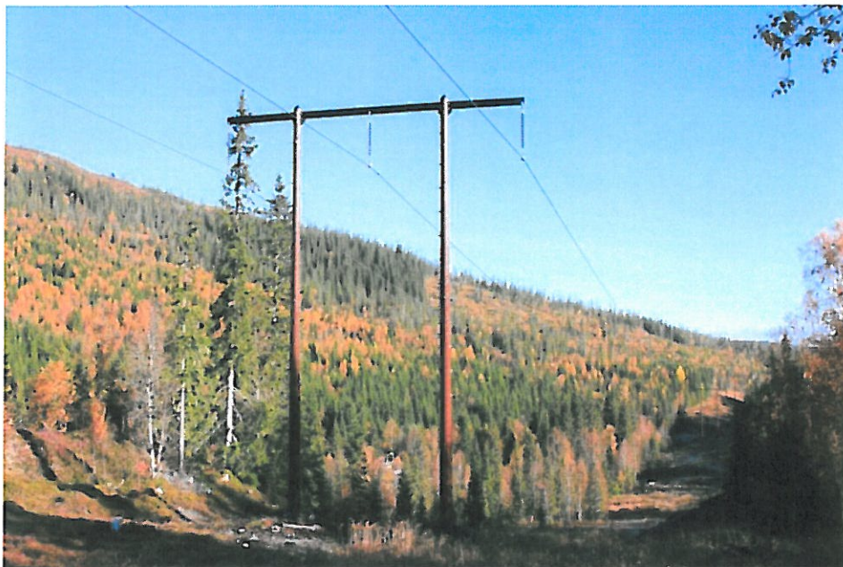
Fig. 21 Foto av lignende 132 kV H-mast med komposittstolper
