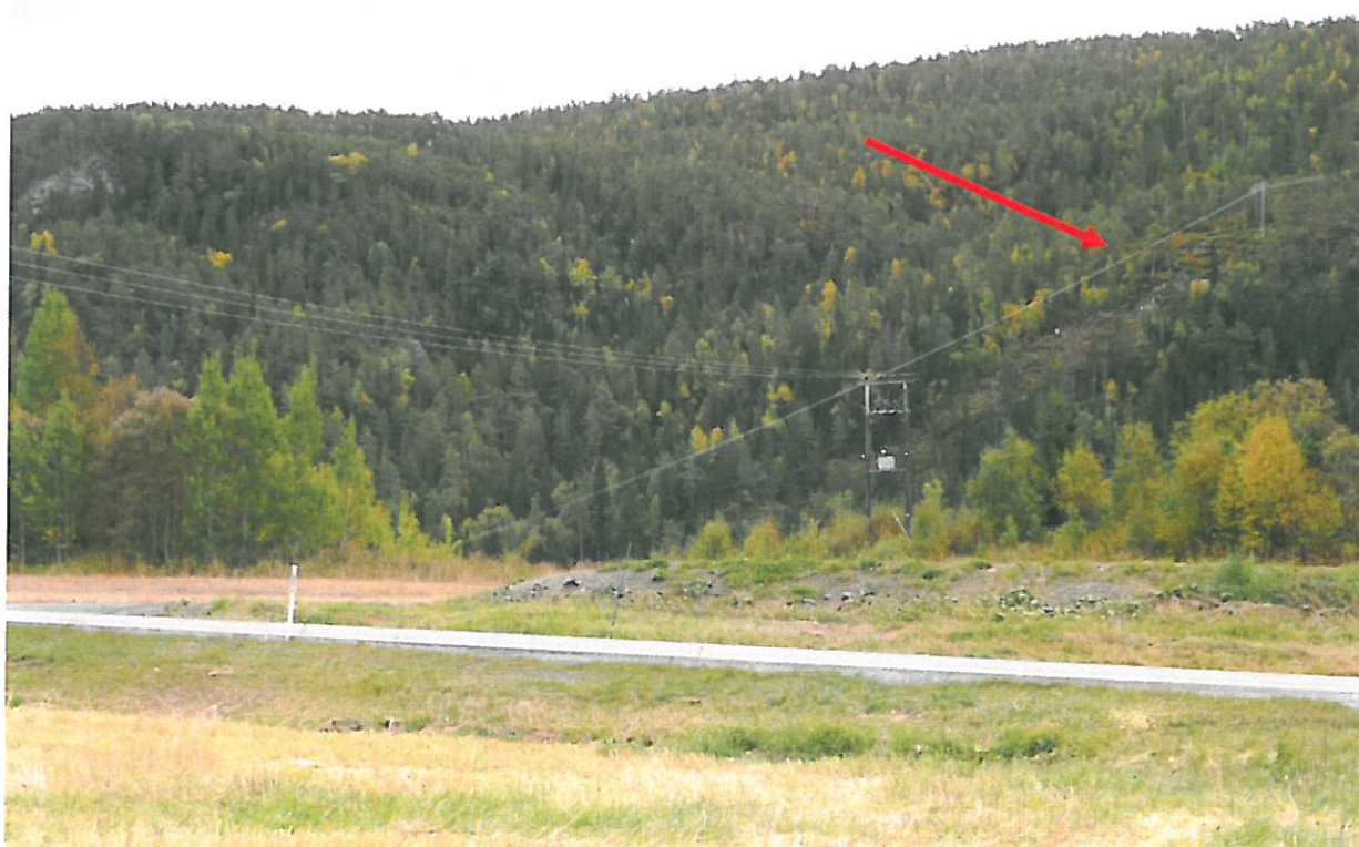
Fig. 7 Eks. 66 kV ledning (rød pil i bakkant av bildet) ved Austre/Vestre Vordalen. Eks. 66 kV ledning blir her delvis byttet ut med ny 132 kV ledning ved Alt 3. Dersom Sutterø-Frosta bygges etter Alt 1/2 fjernes 66 kV ledningen i sin helhet.
