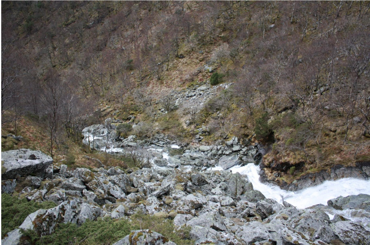
Bilde 10: Ur ved øverste fossefall. Rørgatetrase nærmest fotografen
