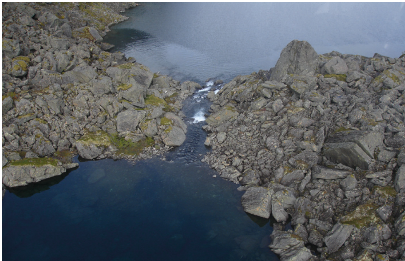
■ Skreddemning (sprenges/graves bort med 5 m) mellom Øvre Rumbojavre 459 moh. og Midtre Rumbojavre 457 moh. – sett mot nord.
