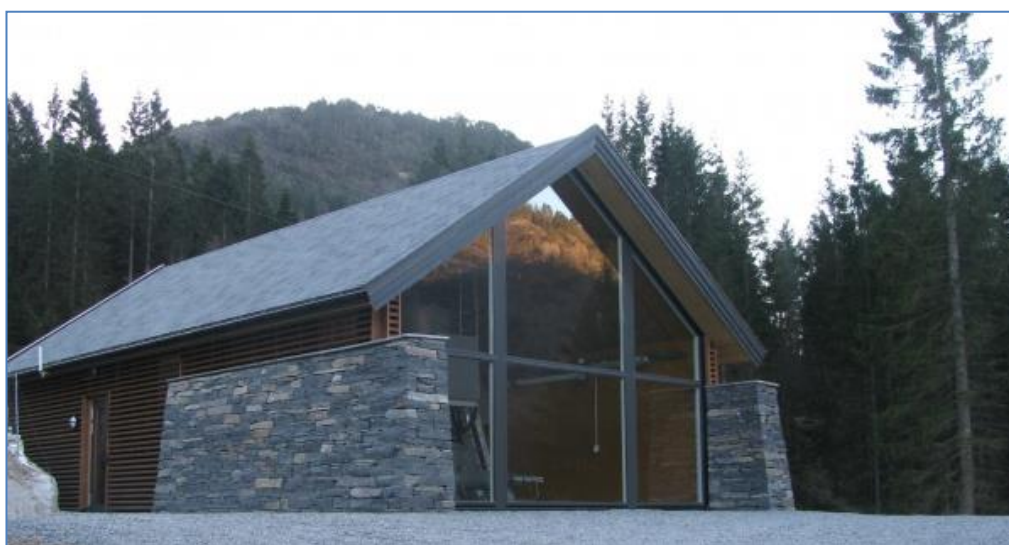
Figur 15. Bilde fra Blådalselva Kraftverk, Masfjorden
