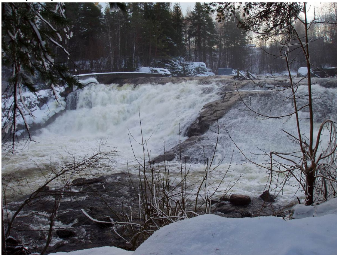
Figur 8. Vinterbilde fra Oterholtfossen; vassføringen er påvirket av tappingen fra Sundsbarmmagasinet. Inntaksterskelen bygges på toppen av fossen. Foto: Svein Lerum
