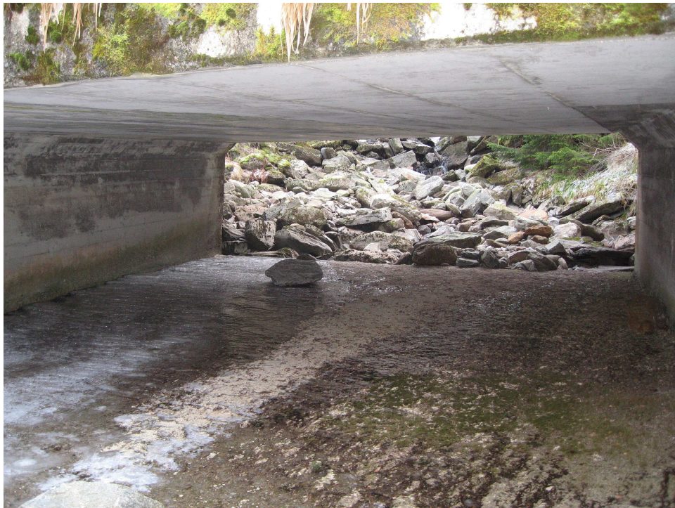
Kulverten er 7 m bred og 2,3 m høy
