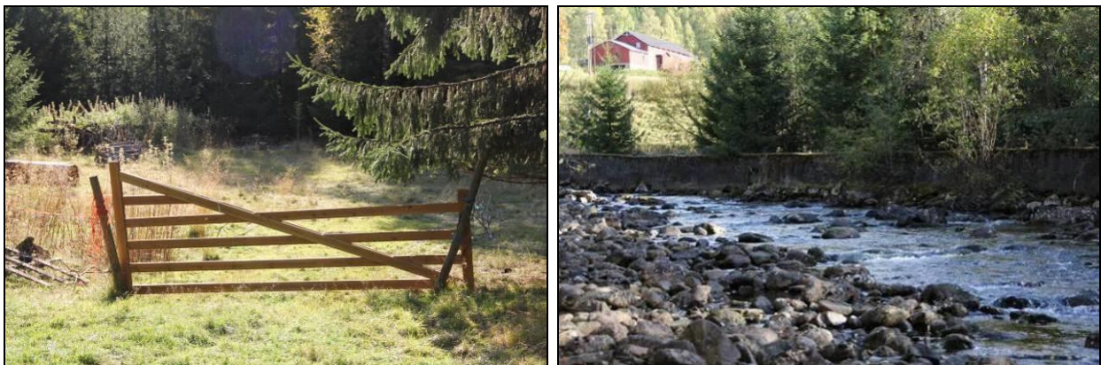
Figur 20. Gammelt kulturlandskap langs Todøla ved Bråten. Arealene beites i dag av sau (venstre). Forstøningsmur bygget langs Todøla om lag kote 200 for å lette fløtningsarbeidet og forhindre tap av matjord på tilliggende dyrket mark (høyre). Foto: Ole Kristian Spikkeland.
