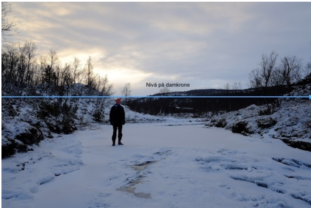
Bilde 1 og 2. Damsted og kraftstasjonsområde.
