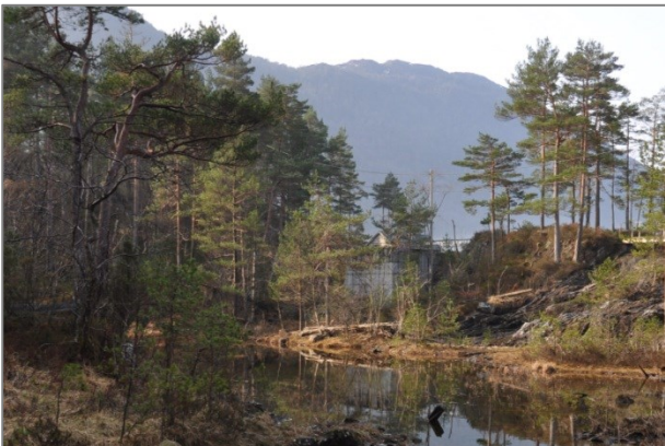
Bilde 18: Dam 2 fra nedsiden
