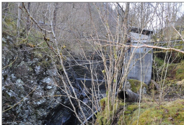
Bilde 2: Inntaksdam til sagbruk
