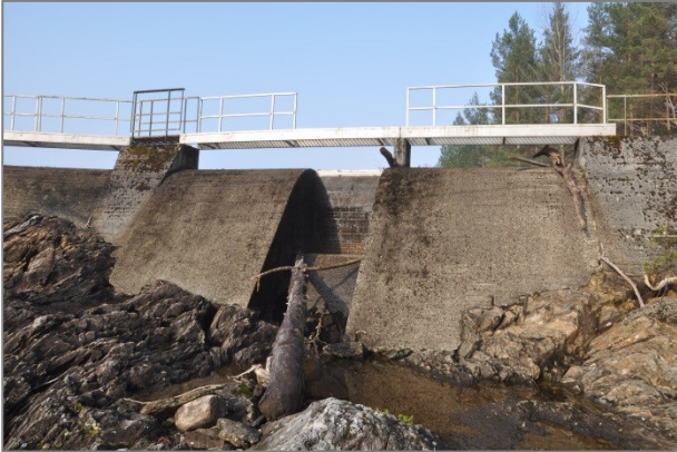
Bilde 16: Dam 1 fra nedsiden
