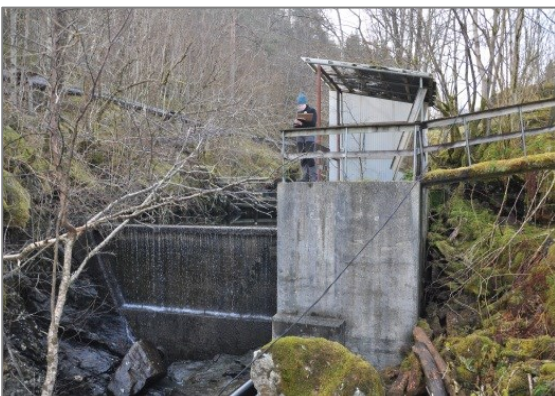
Bilde 20: Dam ved inntak sag
