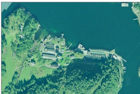
Bilde 7: Flyfoto av anlegget
