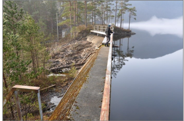
Bilde 17: Dam 1 fra ende dam
