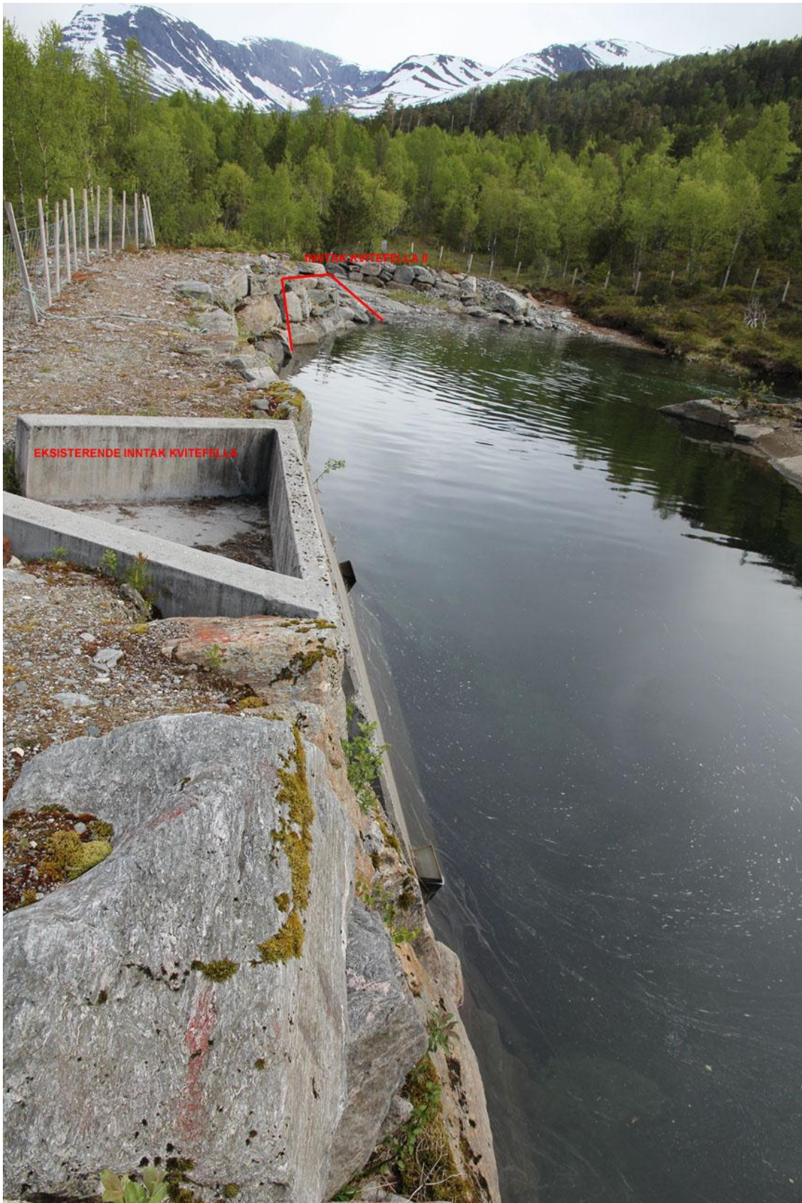
Bilde 1 – Inntaksdam, inntakskonstruksjon for eksisterende Kvitefella Kraftverk i forgrunnen. Inntak Kvitefella II planlegges plassert som inntegnet.
