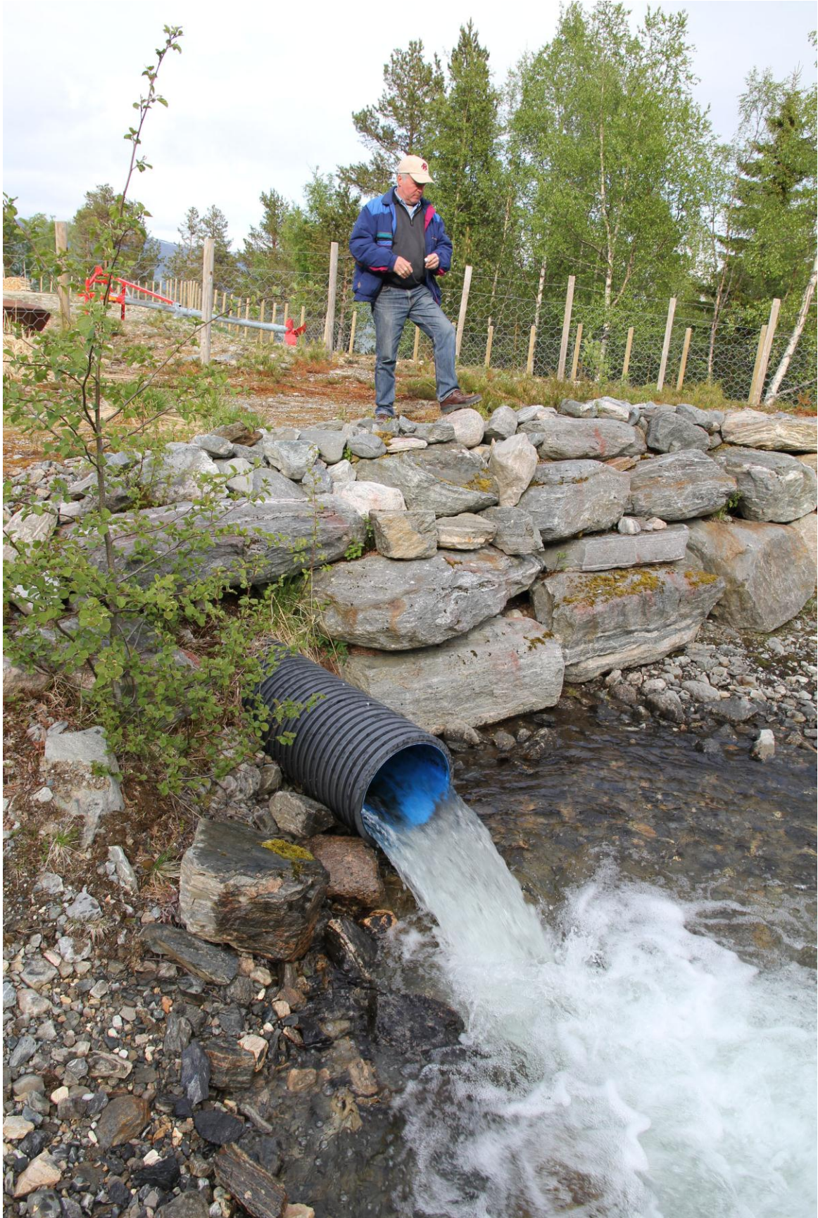
Bilde 2 – Overføringsledningen fra Daudfosselva.
