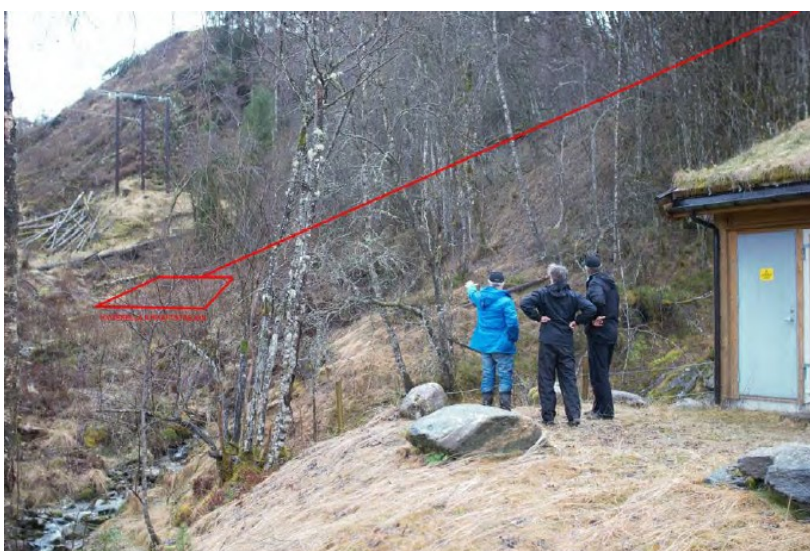
Eksisterende kraftstasjon til høyre. Ny rørgate og ny stasjon på andre sida av elva er markert med raud strek.
