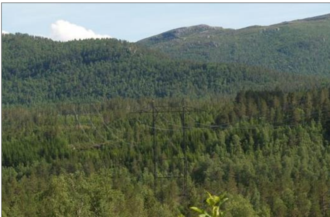
Figur 12: Bilde av kamuflert kraftledning.
