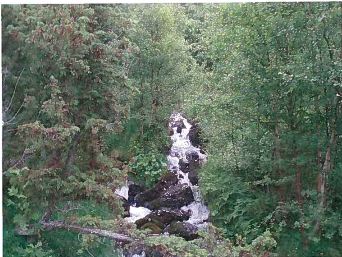
Område for inntak i Naustelvi
