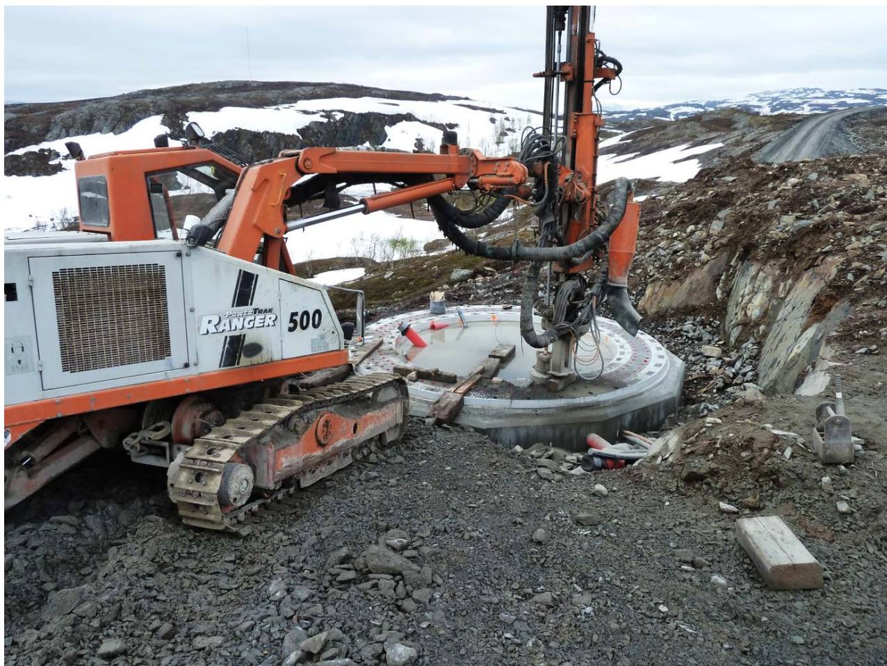
Figur 6.4: Boring av fjellfundament, Nygårdsfjellet i Narvik.
