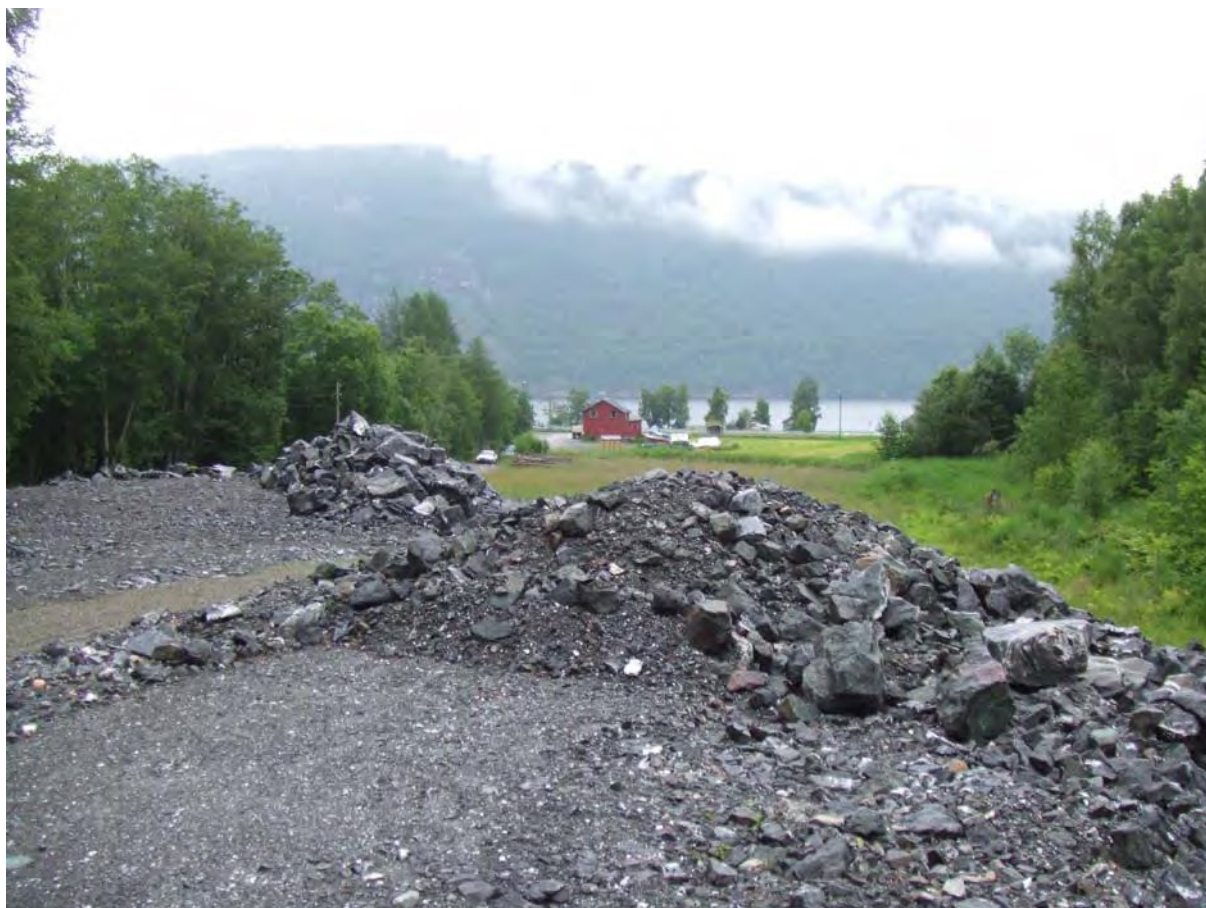
Bilde 9: Bildet er tatt fra stasjonstomten og viser at det er etablert gode fundamenter for stasjon og solid veg.
