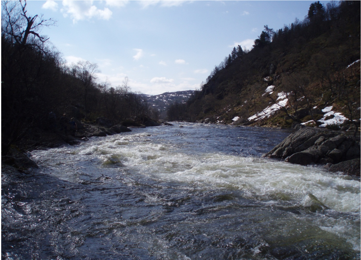
Deler av rørtrase for Skothomtjønn kraftverk og bildet er tatt den 20.05.2010
