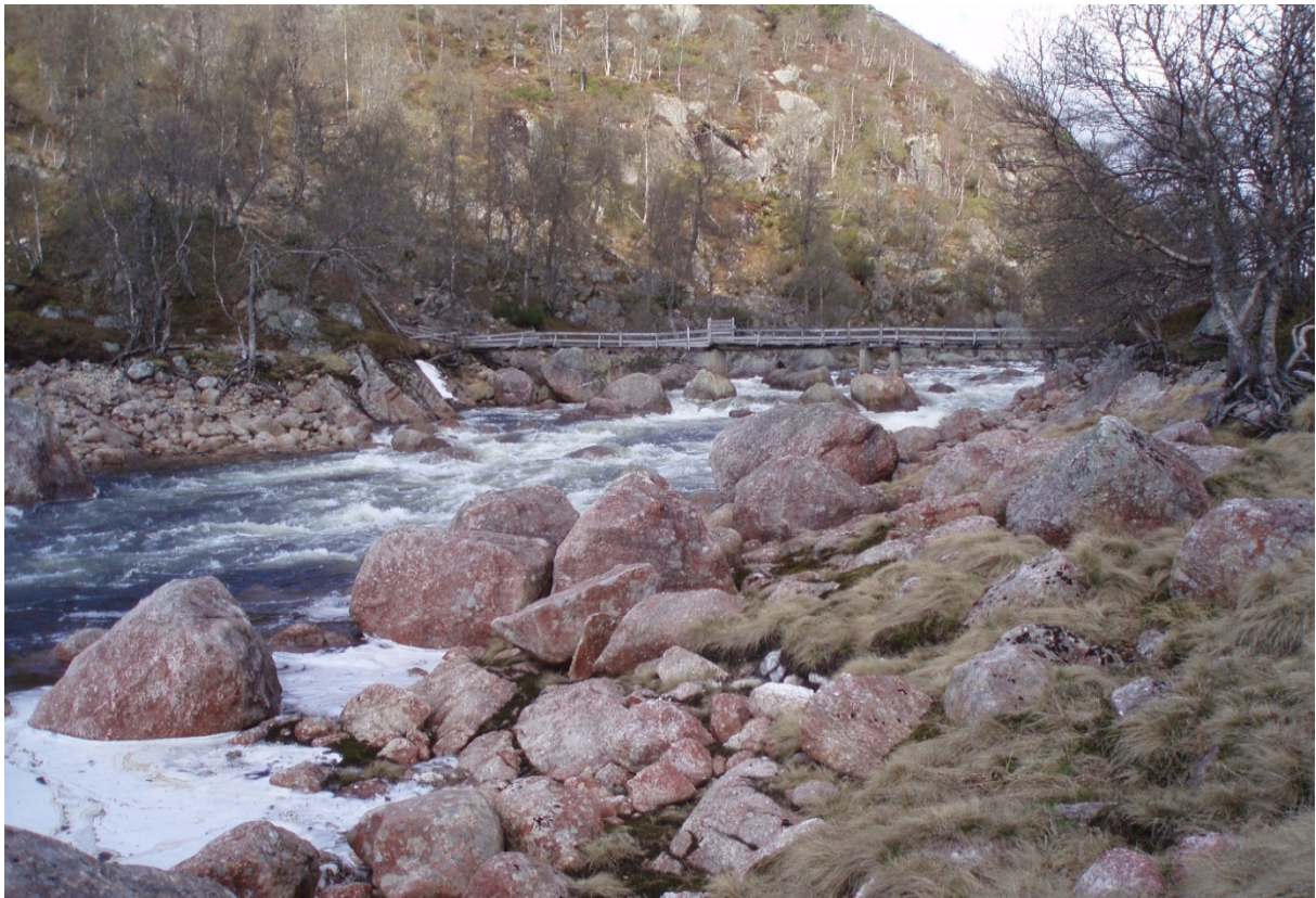
Bildet viser område for kraftstasjonsplassering for Skothomtjønn kraftverk og er tatt 20.05.2010.
