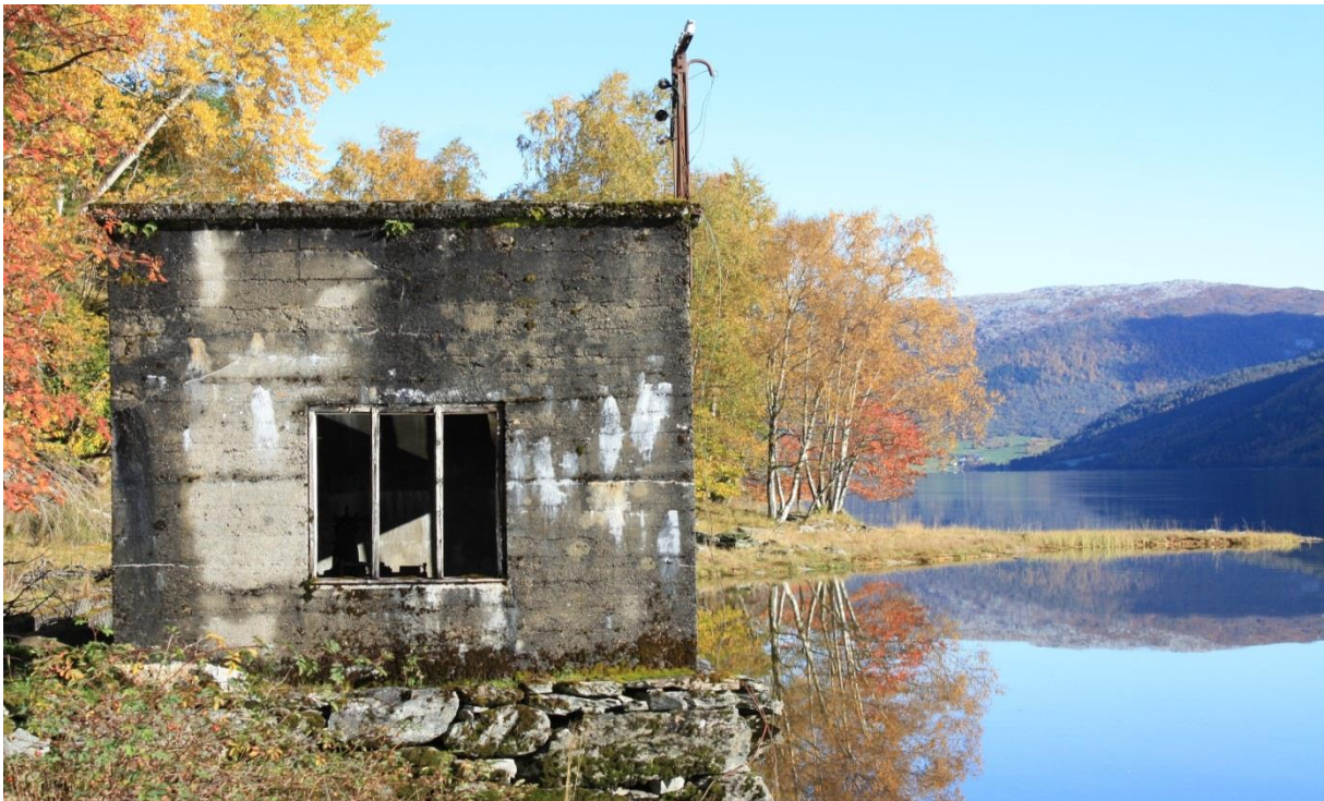
Bilde 13: Restar etter den gamle kraftstasjonen ved Storefjorden.
