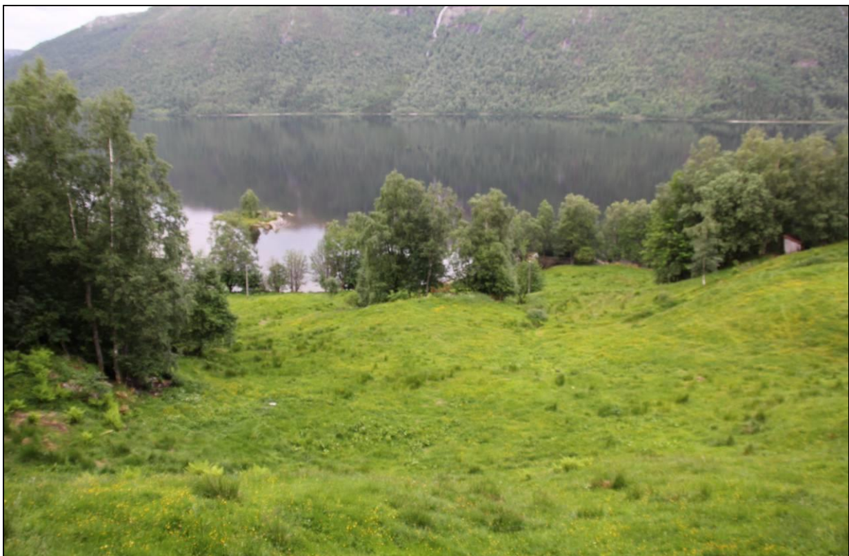
Figur 5. Gjennom dette området mellom Fv615 og Storfjorden skal vannvei graves ned. Mot høyre bygges tilkomstvei til kraftstasjonen, mens jordkabelen for nettilknytning legges gjennom skogsteigen til venstre. Foto: Ole Kristian Spikkeland.
