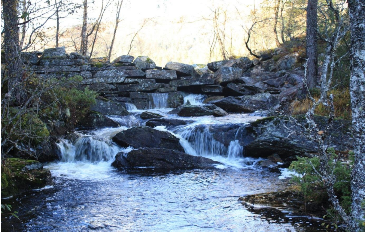
Bilde 2: Gammel demning sett nedstrøms utløpet av Storelva.
