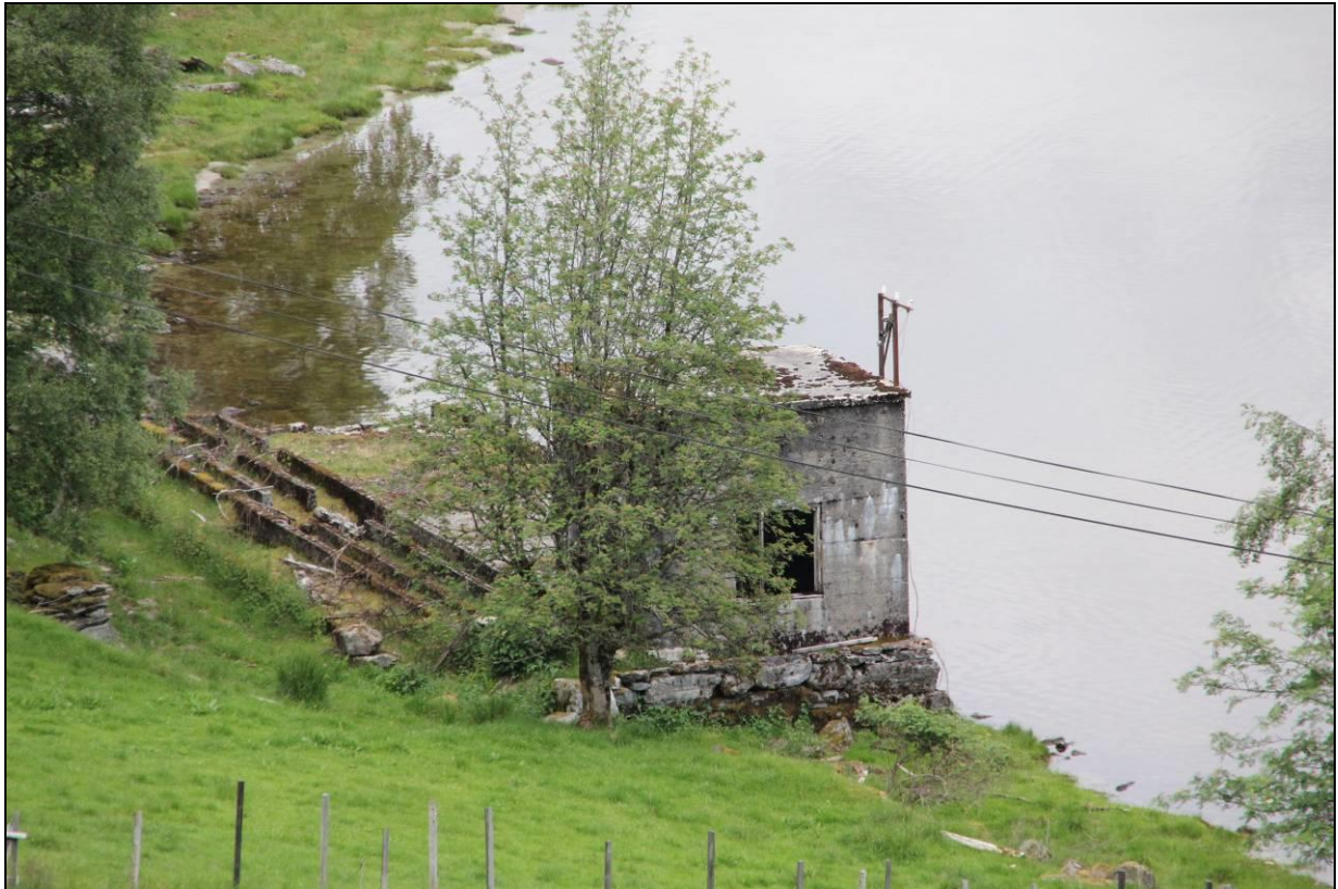
Figur 4. Kraftstasjonsområdet for Solheim kraftverk, kote 127, ved Storfjorden, nær gammelt privat kraftverk som var i bruk fram til midten av 1950-tallet. Foto: Ole Kristian Spikkeland.
