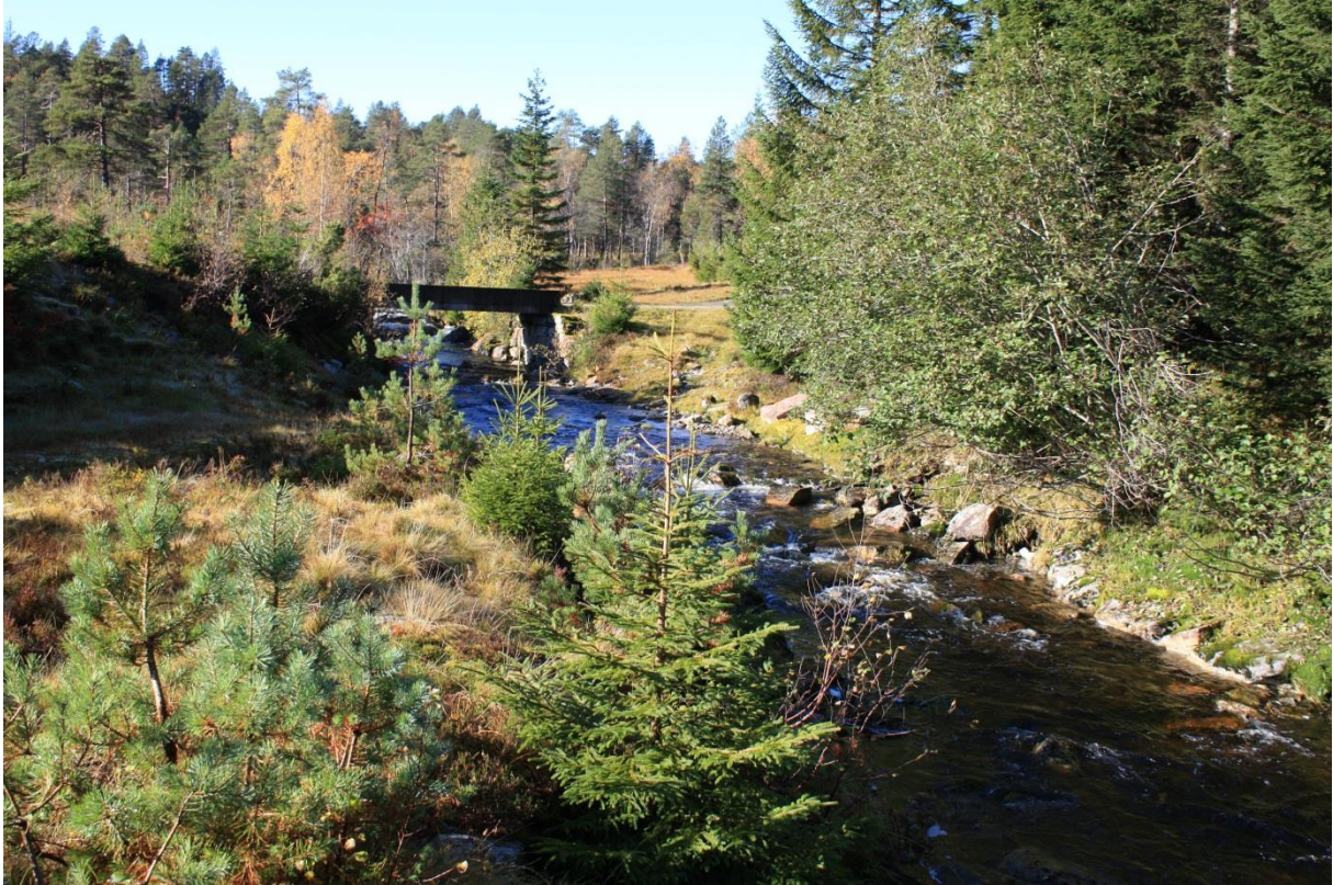
Bilde 6: Siste bru på skogs-/stølsveg. Denne vegen vil bli nytta både i anleggsfasen og driftsfasen.
