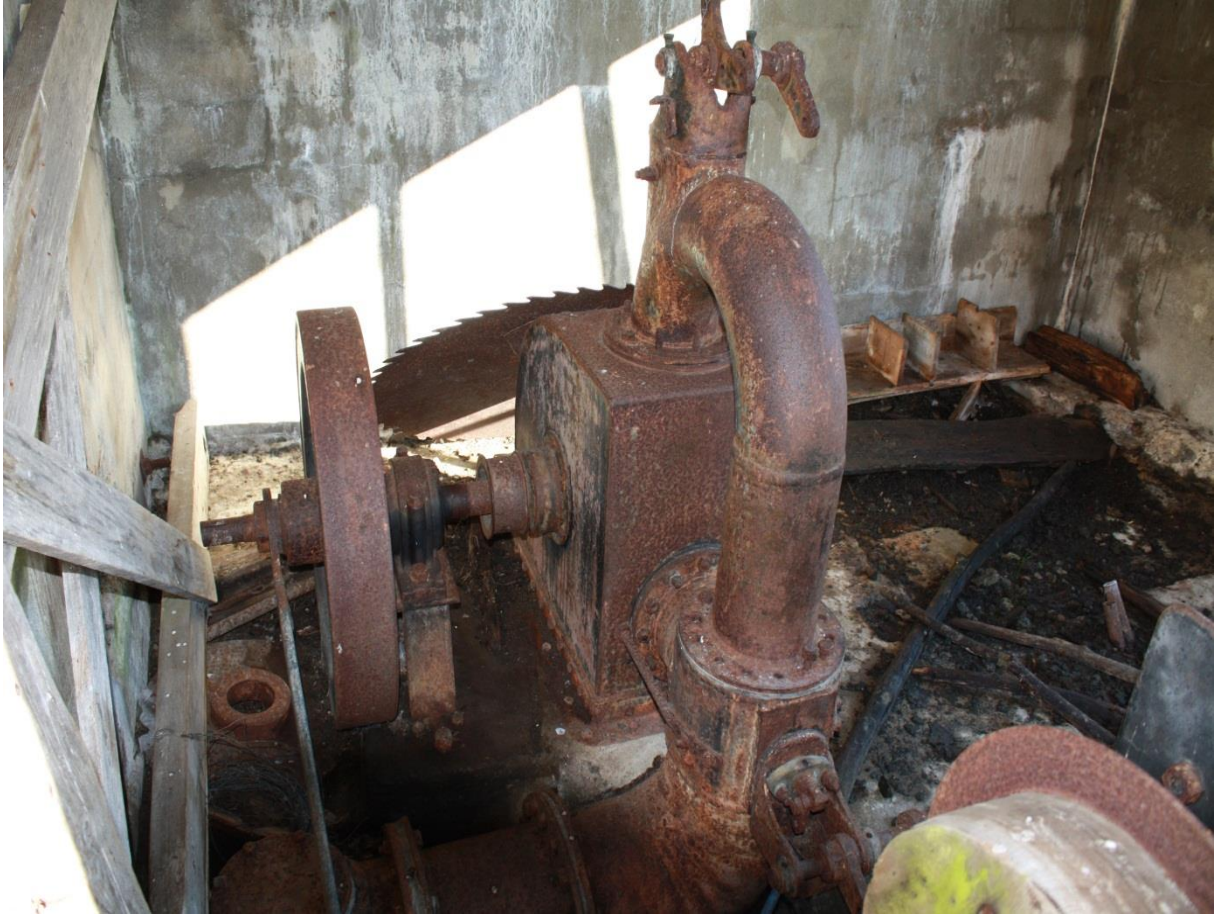
Bilde 14: Innvendig i den gamle kraftstasjonen ved Storefjorden.
