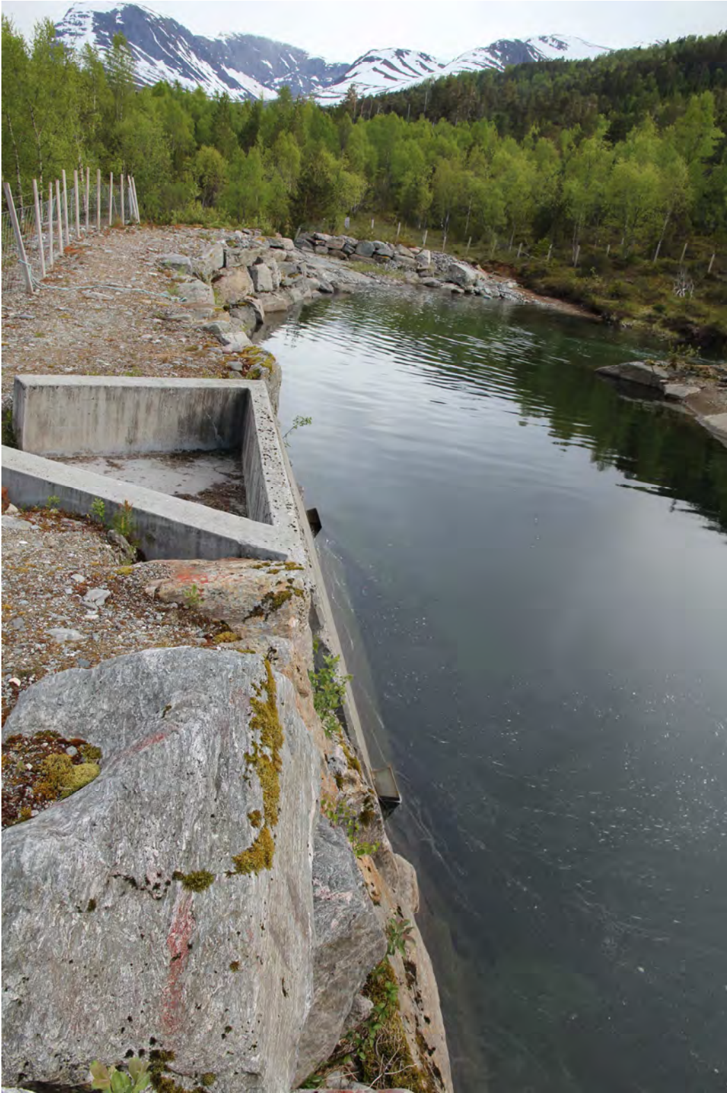
Nærbilde av rist på eksisterende inntak på Kvitefella Kraftverk
