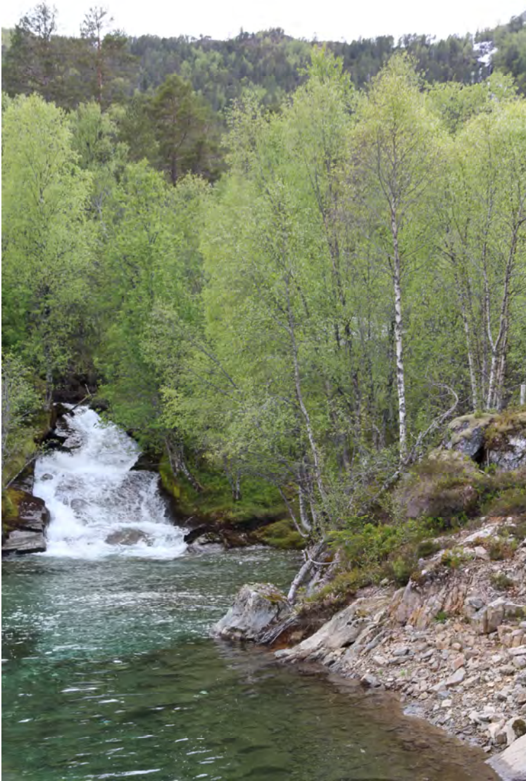
Kvitefella renner inn i inntaket på eksisterende Kvitefella Kraftverk
