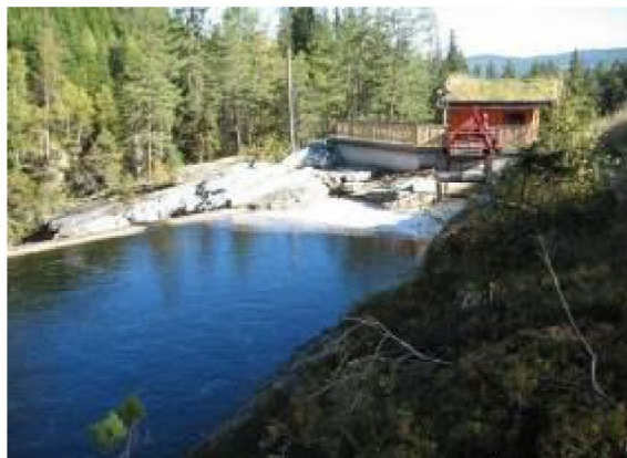
Bilde 14: Inntaksbasseng Nørståe I. Foto: Elvekraft
