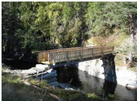
Bilde 13: Gangbru oppstrøms demning til Nørståe I. Foto: Elvekraft
