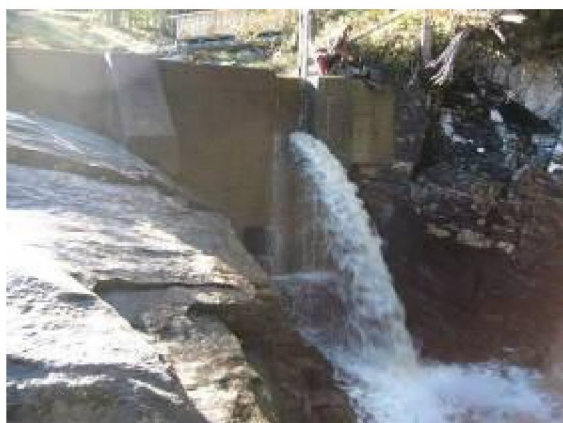
Bilde 15: Minstevannsslipp Nørståe I. Foto: Elvekraft
