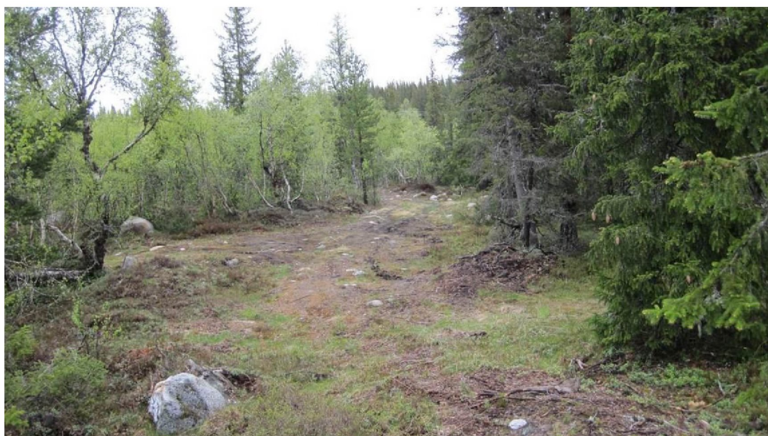
Bilde 6: Traktorslepe hvor rørtraséen legges. Foto: Elvekraft
