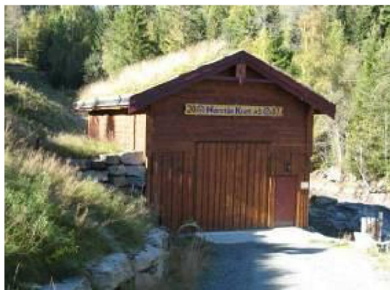
Bilde 12: Kraftstasjon Nørståe I. Foto: Elvekraft
