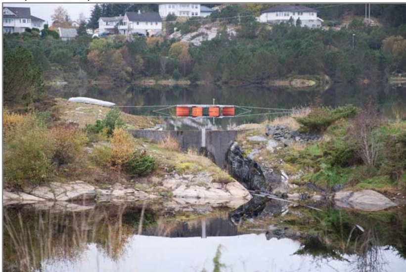
Bilde 11: Bilde av flytekonstruksjon for inntaksledning, dam, og magasin basseng.
