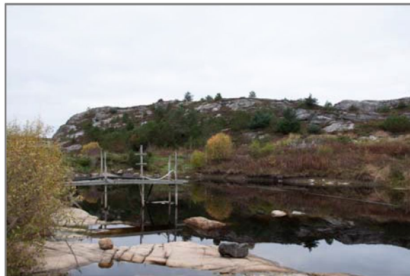
Bilde 4: Inntaksdam med ringsløyfe i vegetasjon.
