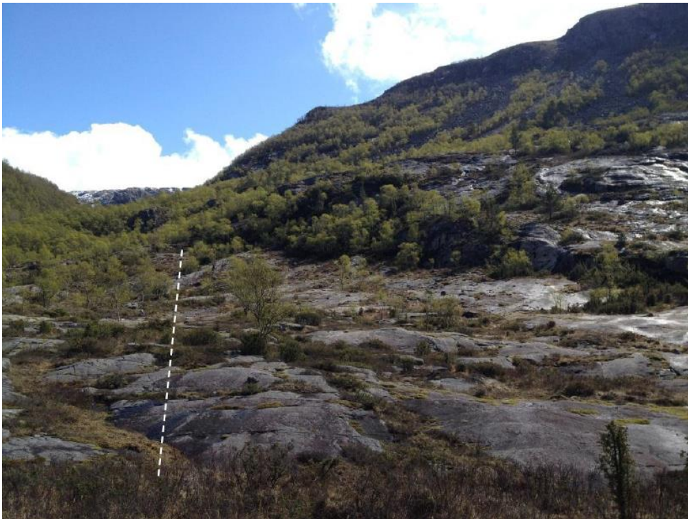
Figur 6 - Rørgatetrasé fra tunnel til kraftstasjon
