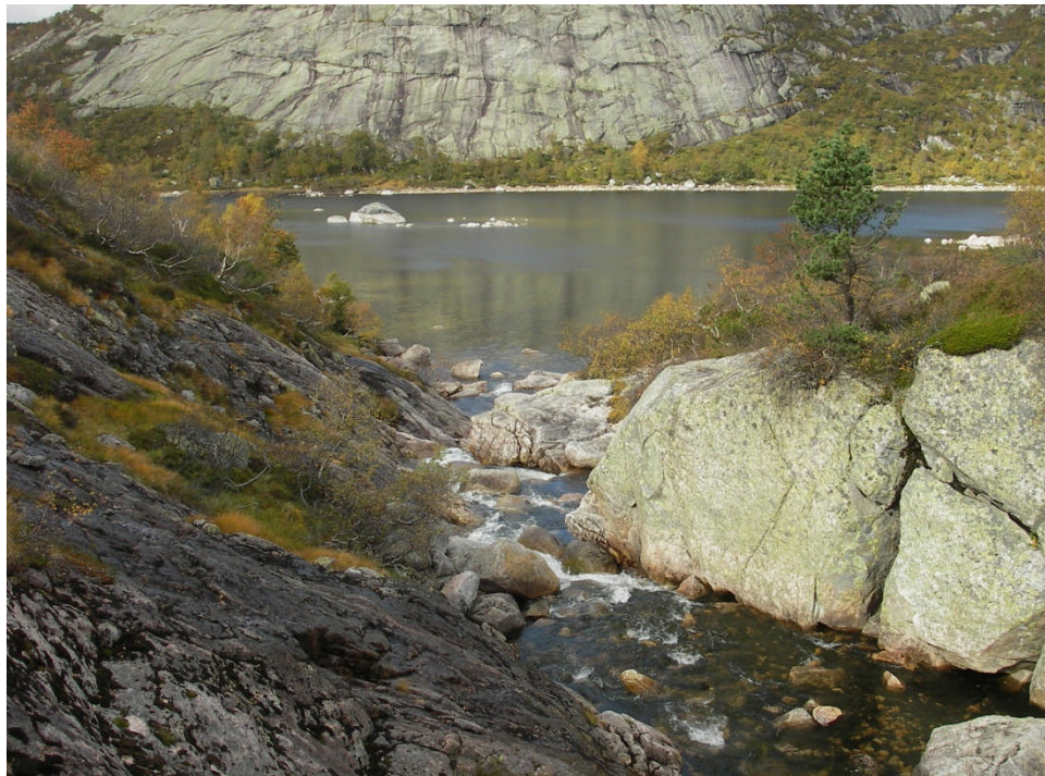
FIGUR 7: BILDET VISER KRAFTSTASJONSOMRÅDE I ØSTRE ENDE AV STORHOMSTJERN.
