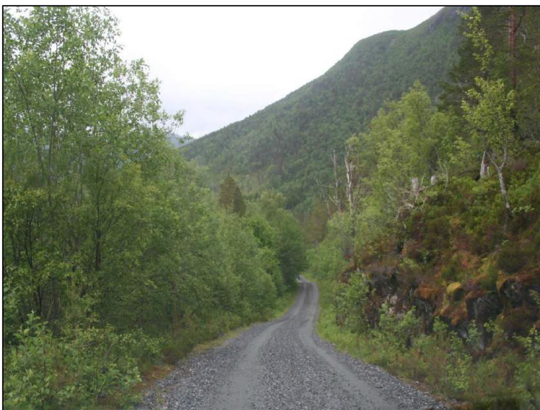
BILDE 9: RØRGATA LEGGES I KANTEN AV VEIEN.
