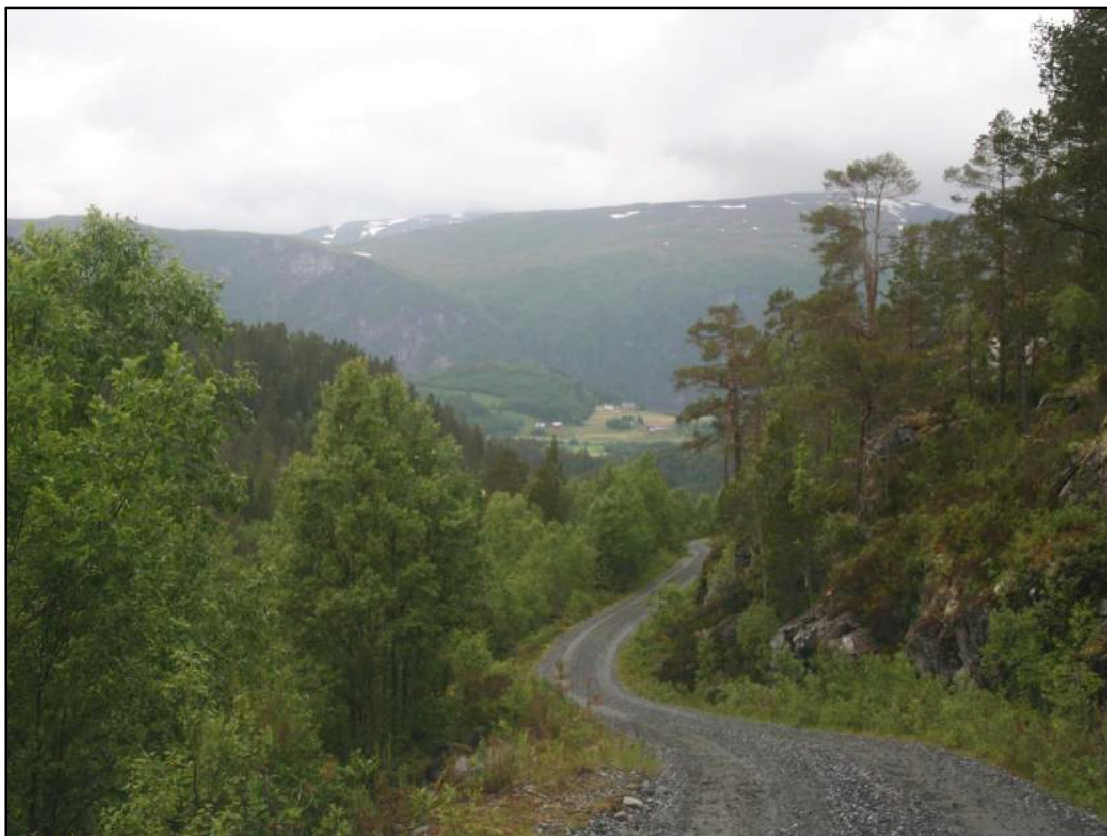
BILDE 8: RØRGATA LEGGES I KANTEN AV VEIEN.
