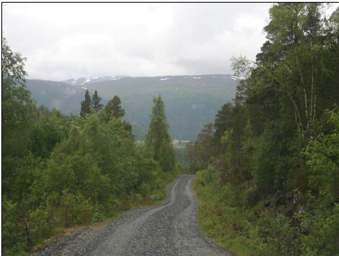
BILDE 7: RØRGATA LEGGES I KANTEN AV VEIEN.
