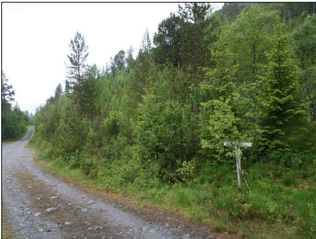
BILDE 6: ØVRE DEL AV RØRGATETRASEEN OMKRING 400 M FRA INNTAKET..RØRGATA VIL GÅ RETT FRAM OG FØLGE VEIEN. DEPONI BLIR ANLAGT TIL HØYRE I BILDET.
