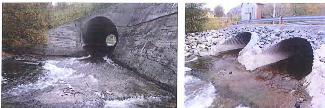
Figur 4-8. Bilder av kulvertene i Vikelva. Det venstre bildet viser den øvre kulverten, mens det høyre bildet viser de nedre kulvertene. Begge bildene er tatt fra nedstrøms kulvertene ved vannføring på 0,8 \text{ m}^3/\text{s} .
