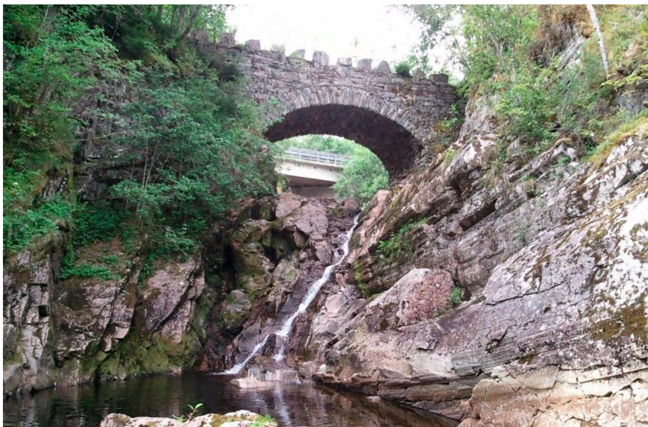
Figur 34 : Anadrom sperre ved Eidsfossen 12.8.2010
