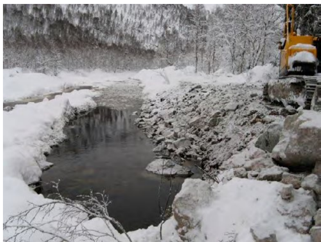
Figur 38 : Bilder fra forbygning i Hundsåa 2007.
