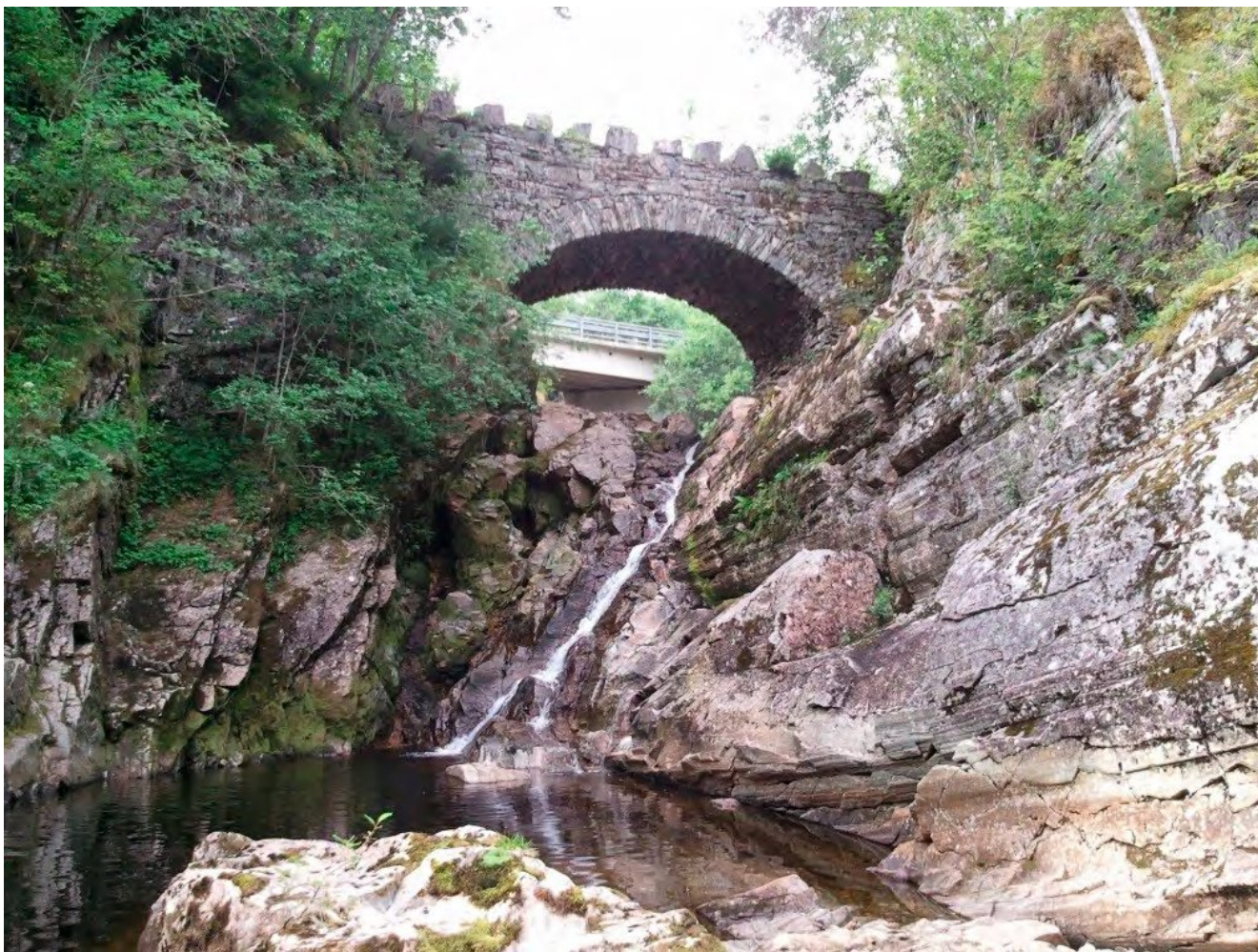
Figur 41 : Eidsfossen, slutt på lakseførende strekning i Eidselva/Søa.
