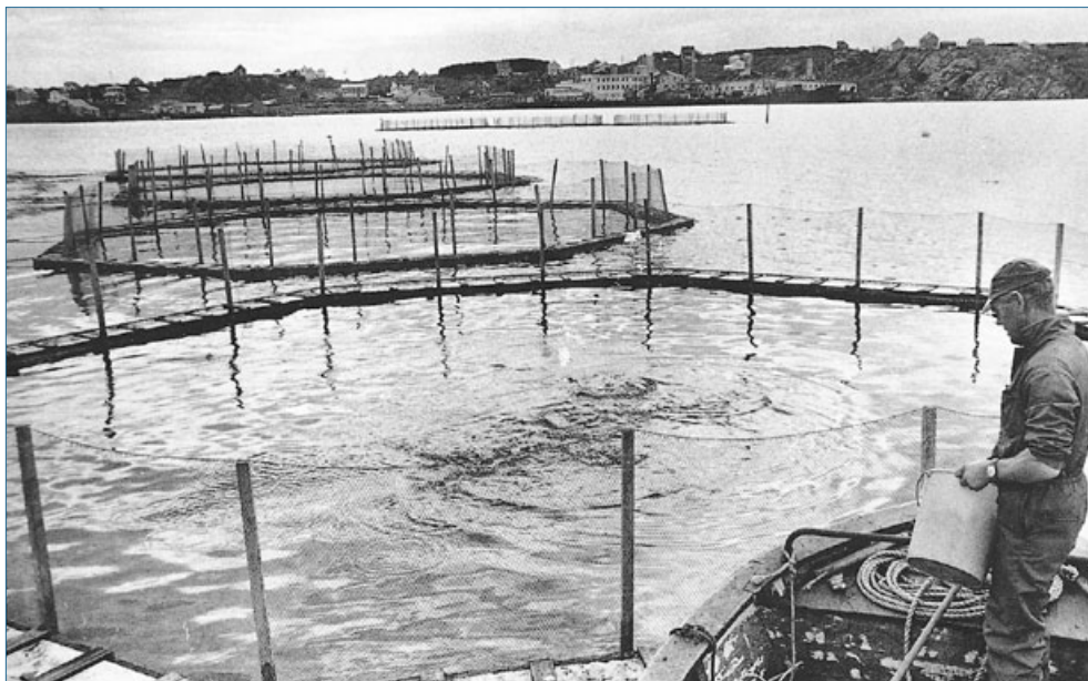
Alfred Kristiansen ved oppdrettsmerdene i Klauvasundet 1972-73. Det var åttekantede merder (Grøntvedt-merder) av impregnert treverk med isoporklosser som flottører. De åtte sidene var festet sammen med gummi fra bildekk. Foto: Adresseavisen.
