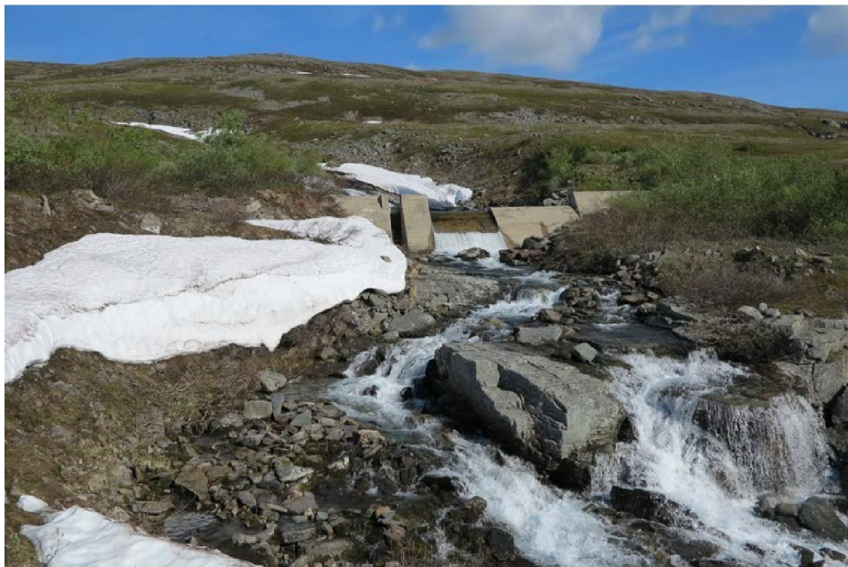
Figur 5. Demningen i Neptunelva sett nedenfra.
