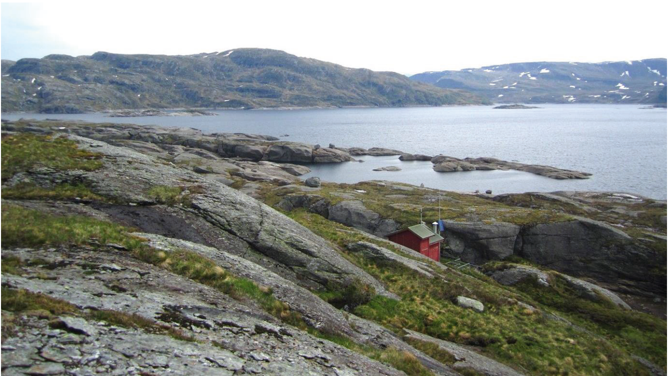
Figur 2-3 Eksisterande lukehus ved Løkjelsvatnet, til inntak Hardeland kraftstasjon. I fylgje planen vil dette inntaket bli brukt til nye Løkjelsvatn kraftverk. Alternativ nytt inntak vil leggjast nord for det eksisterande.
