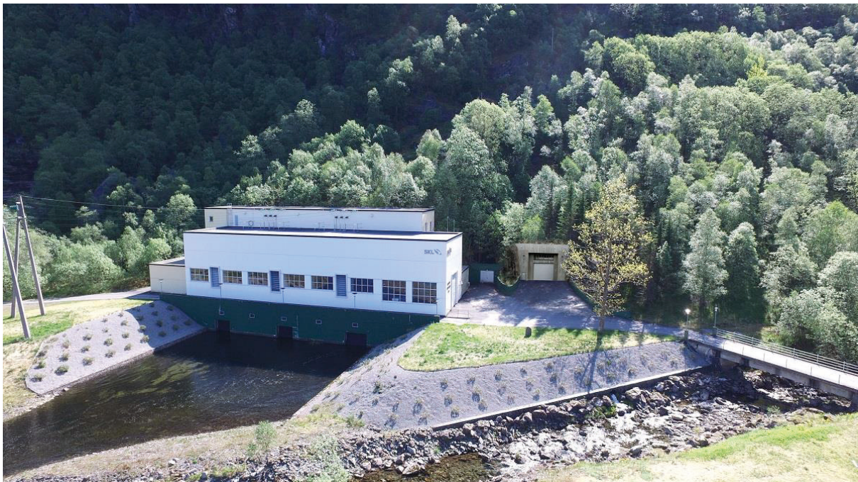
Figur 2-10 Visualisering påhogg ved Hardeland kraftstasjon, tilkomsttunnel til Løkjelsvatn kraftverk. Før og etter.
