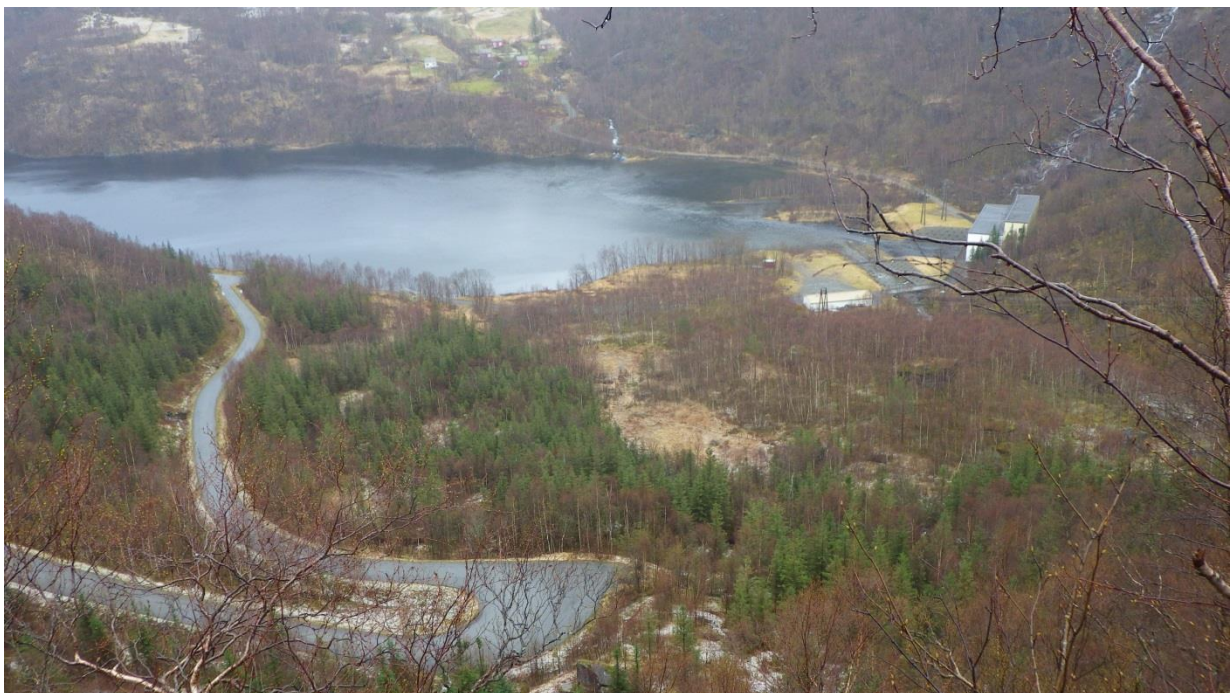
Figur 7-10 Oversiktsbilde over tippene ved Hardelandsvatnet, sett ovenfra
