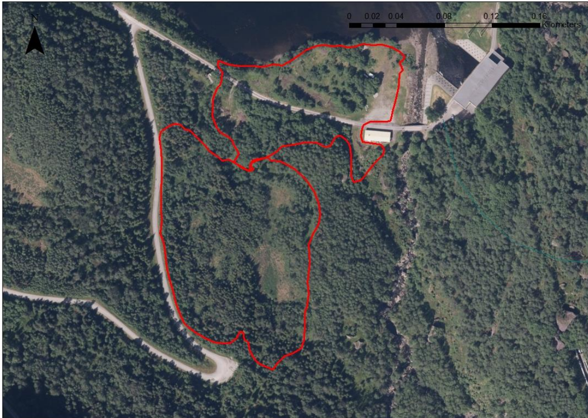
Figur 7-8 Flyfoto Hardeland kraftstasjon og de to tippområdene
