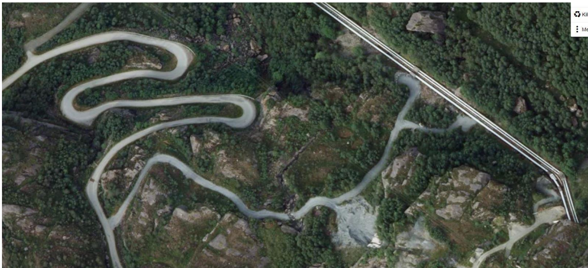
Figur 6-9 Utklipp fra gulesider.no som viser eksisterende situasjon rundt riggområdene ved Skarstøl
