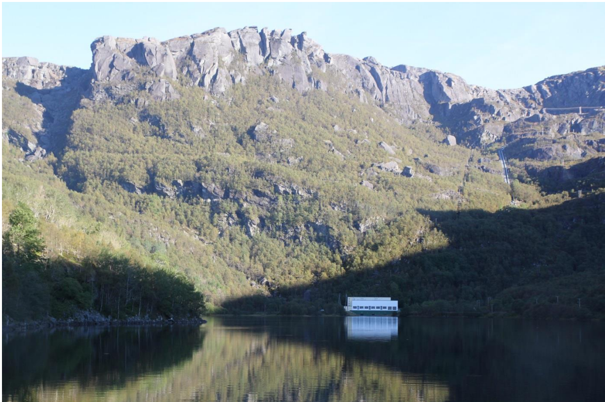
Figur 9-4 Hardeland kraftverk ligger innerst i Hardelandsvatnet med godt synlig rørgate i den bratte skråningen opp mot det bare fjellet. Foto: M. Mortensen, Sweco. Sept -13.
