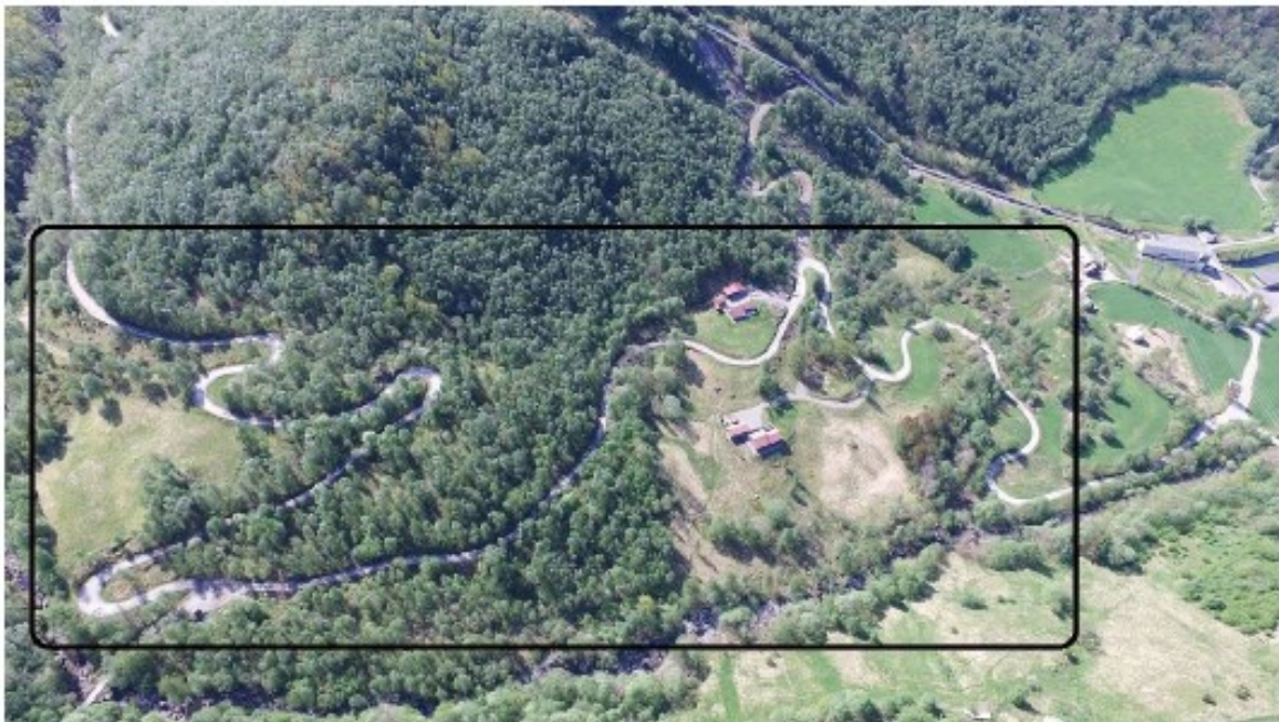
Figur 2-8 Et stykke av vegen mellom Litledalen og Hardeland må oppgraderast
