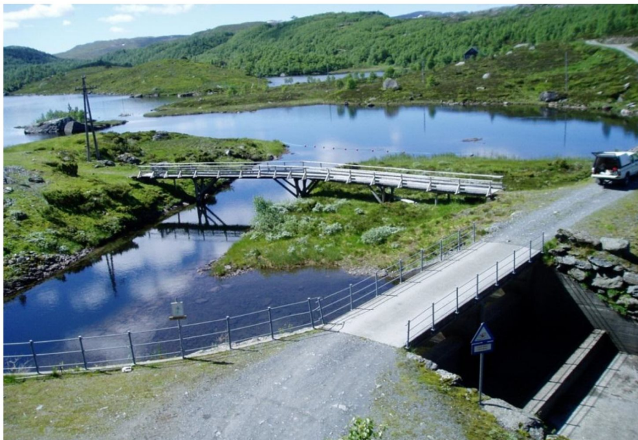
Figur 5. Inntak Hjørnåsvatn (foto Haugaland Kraft).
