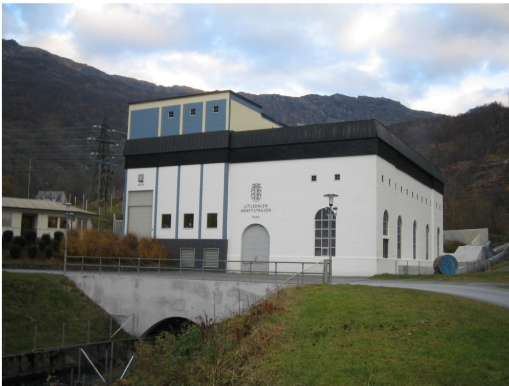
Figur 1. Litledalen kraftverk (foto Haugaland Kraft).
