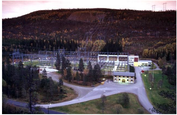
Tunnsjødal kraftverk med utendørsanlegg
