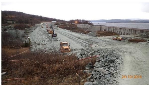
Den gamle dammen ved Namsvatnet og ny fyllingsdam som er under bygging
