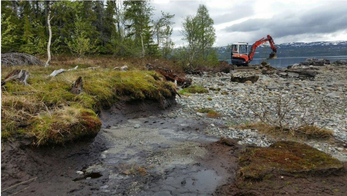
Erosjonssikringstiltak på Reirodden ved Namsvatnet i 2017
