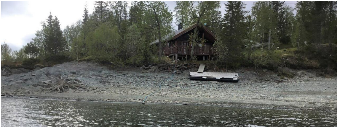
Figur 2-5 Viser hytte med påler som står tett på erosjonskanten.
