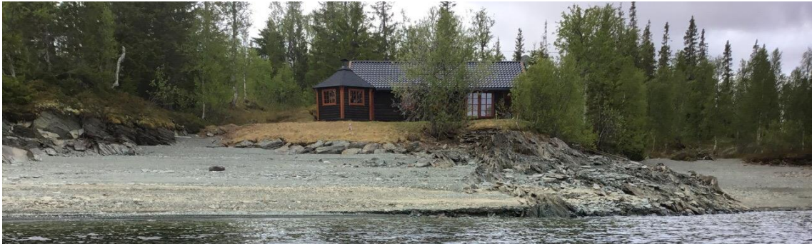
Figur 2-4 Viser hytte med enkel sikring i front.
