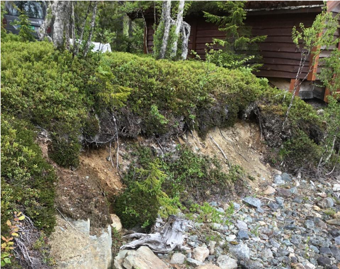
Figur 2-43 Erosjonskant ved garasje.
