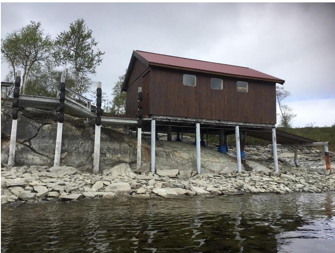
Figur 2-13 Landgangsted for hytter og turisme til Kristi Krybbe (kirke) og Reiret. Godt rustet mot erosjon, og ligger delvis på fjell.
