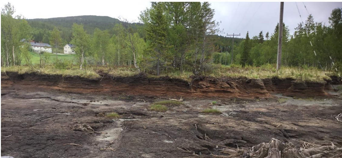
Figur 2-44 Kraftstolpe til høyre i bildet er noe utsatt.
