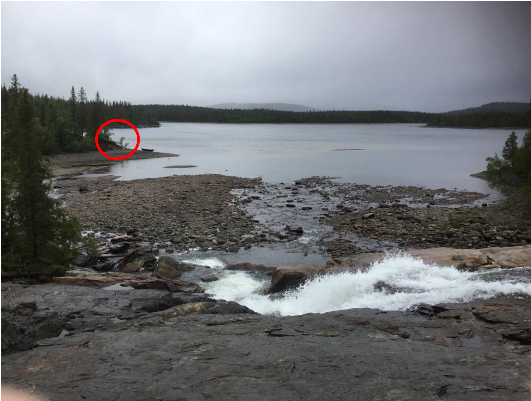
Figur 2-33 Utløpet av Stallvikelva. Noe erosjon på neset vist med rød sirkel.
