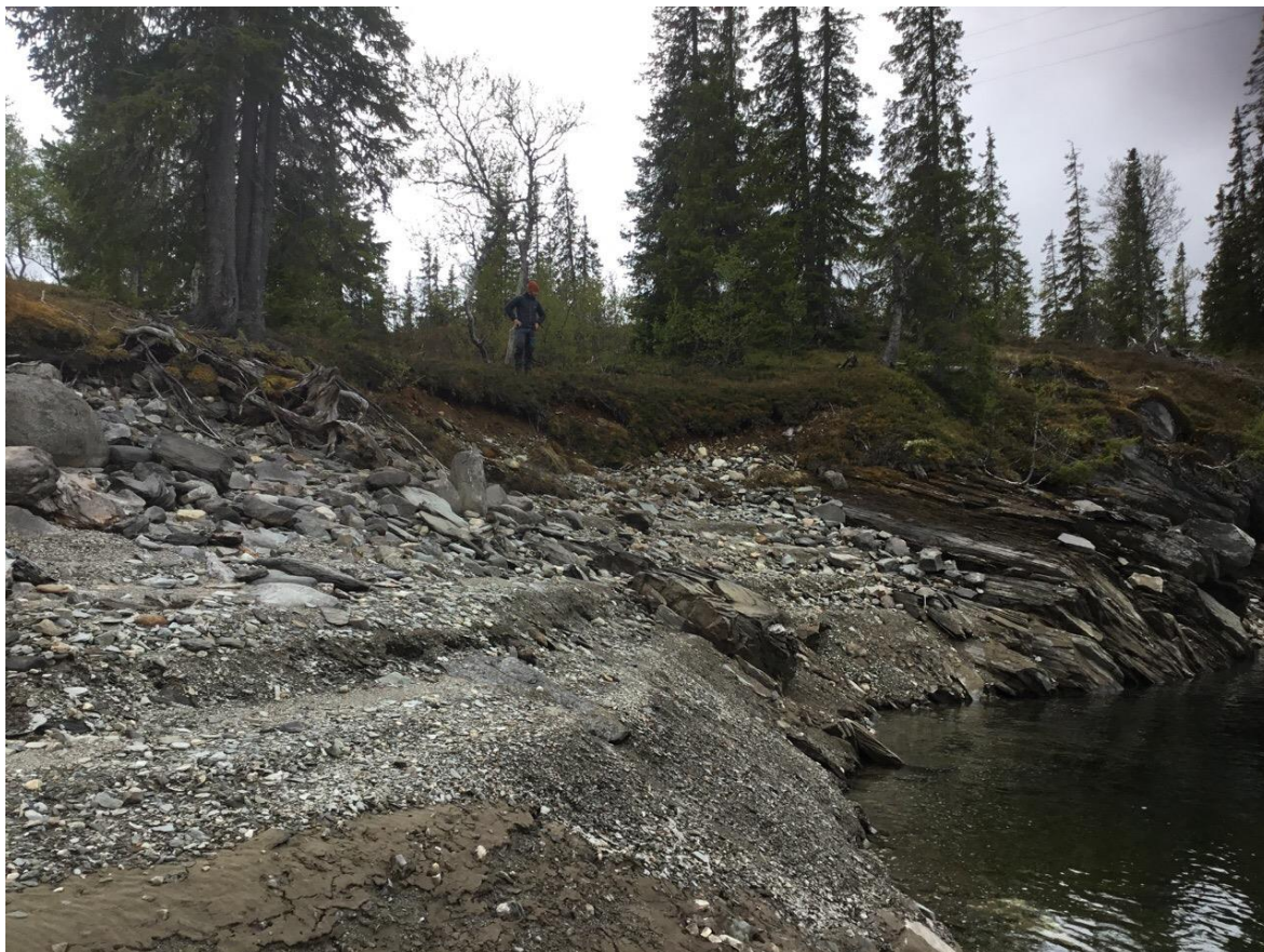
Figur 2-24 Midtibeckens utløp. Det er gravd ned til berg til høyre i bildet, der bekken renner ut i Namsvatnet. Midt i bildet ser vi noe nyere erosjon.
