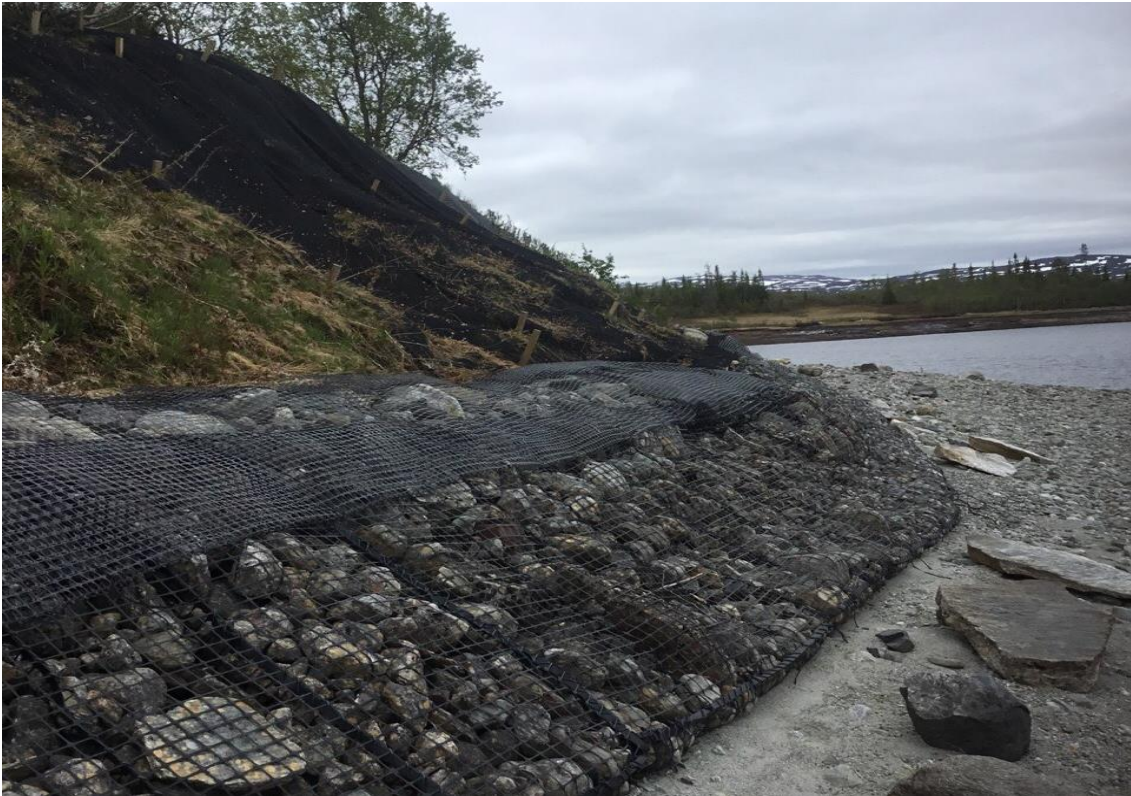
Figur 2-11 Sikringstiltak ved Virmaneset. Geonett og duk er lagt ut for å hindre erosjon.
